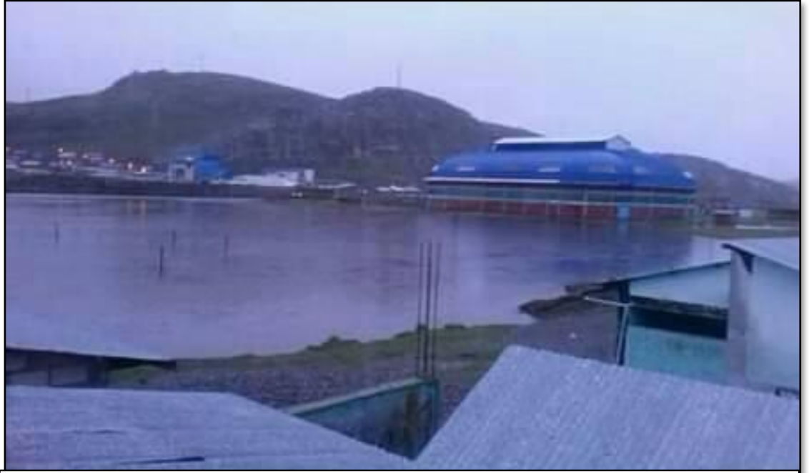
9. Zonas inundadas al margen izquierdo del rio San Juan en la localidad de Rancas, del distrito de Simón Bolívar.
