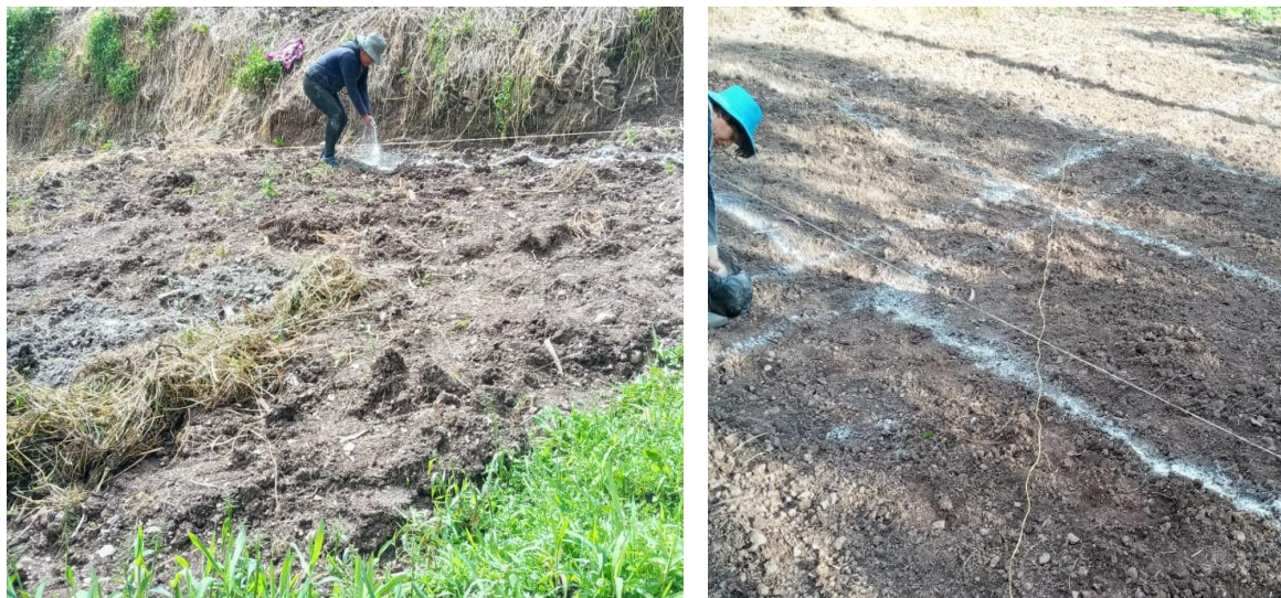
Figura 01: limpieza y preparación de terreno.
