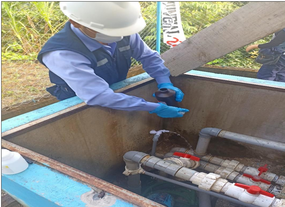
Foto N° 6.- Toma de muestras de agua del reservorio del sistema de abastecimiento de agua del anexo de Mesapata.
