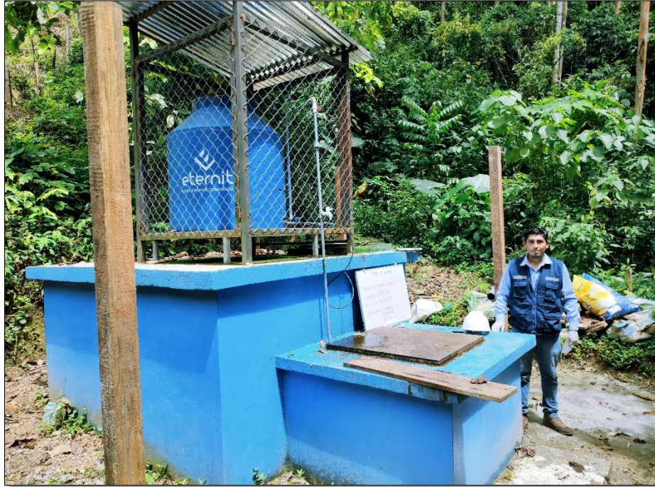
Foto N° 9.- Identificación de la zona de muestreo del sistema de abastecimiento de agua del anexo de Tambo Pituca.
