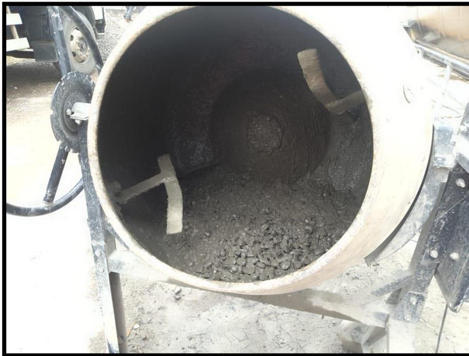
**Fotografía 2.-** Mezclado de materiales en el trompo respetando el tiempo según norma
