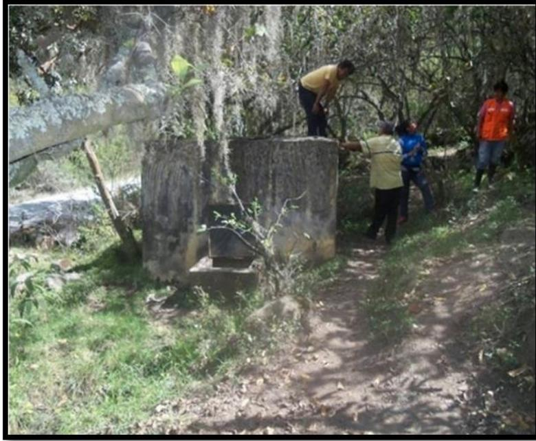
Reservorio existente, semi enterrado, se aprecia el deterioro en todas las paredes y la presencia de moho en la superficie de los muros.
