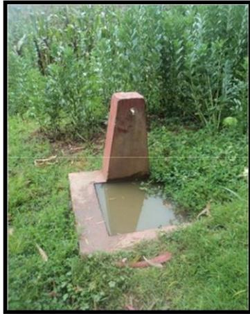
Evacuación de las aguas grises alrededor de la pileta. Se aprecia los empozamientos de agua y acumulación de basura en los puntos de descarga, lo que genera más insalubridad.
