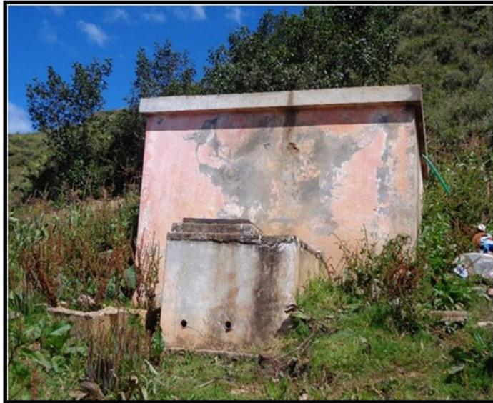
Reservoirio existente, se encuentra semi enterrado por falta de mantenimiento y por la presencia de lluvias en la zona lo que ocasiona que el suelo este cediendo y la antigüedad del reservoirio.
