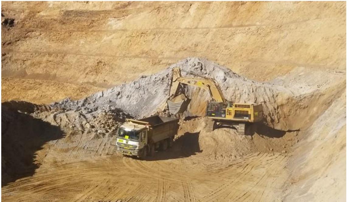
Gráfico 5: Carguío de material con Excavadora
