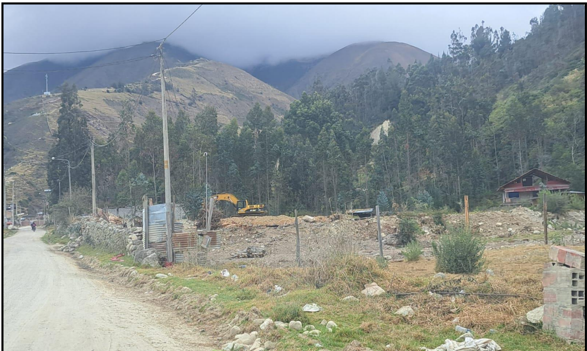
Fotografía N° 004: Vista de las actividades de uso de equipo de maquinaria pesada
