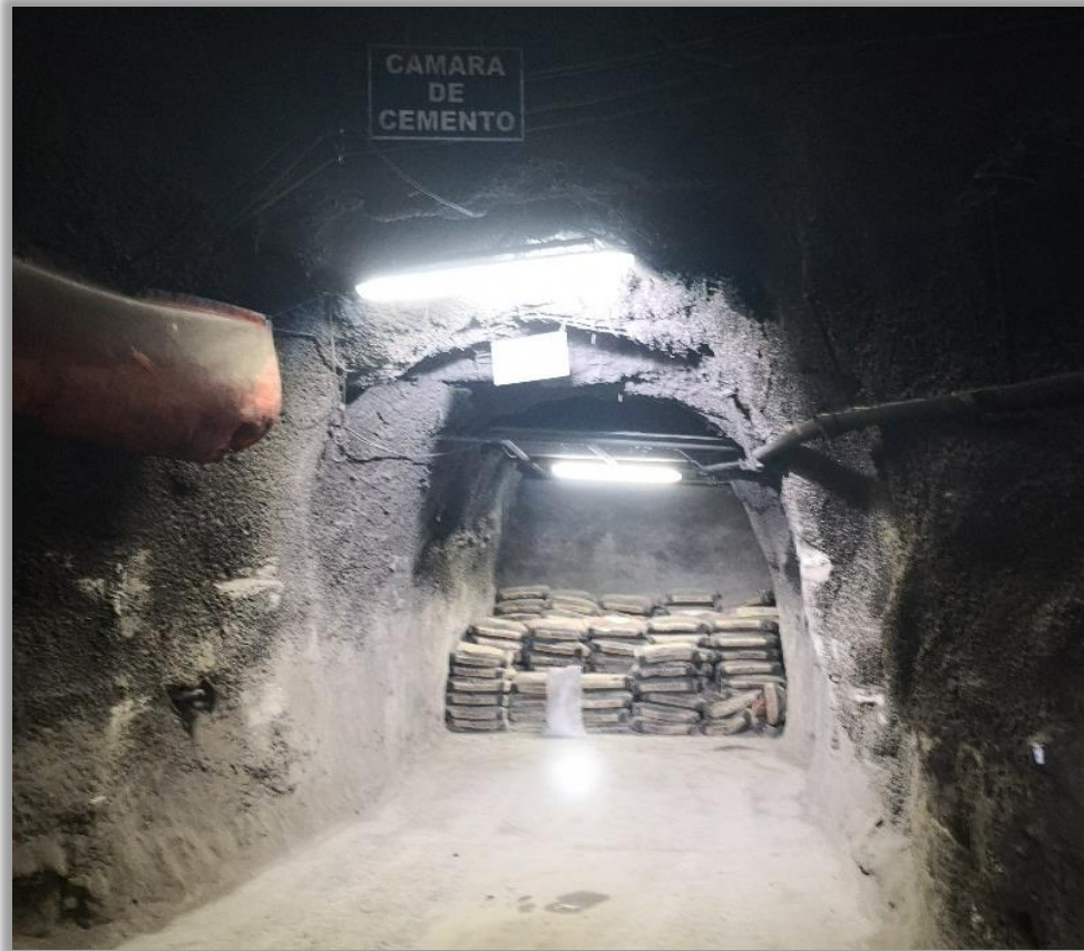
Figura 41. Almacén de Cemento Portland en la Planta de Shotcrete (Nv. 920) Fuente: Elaboración Propia.
