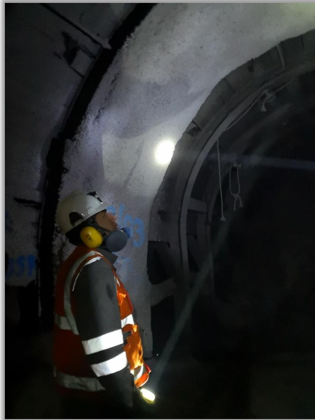
Figura 35. Sostenimiento con Cimbras Metálicas en la Mina Yauricocha. Fuente: Elaboración Propia.
