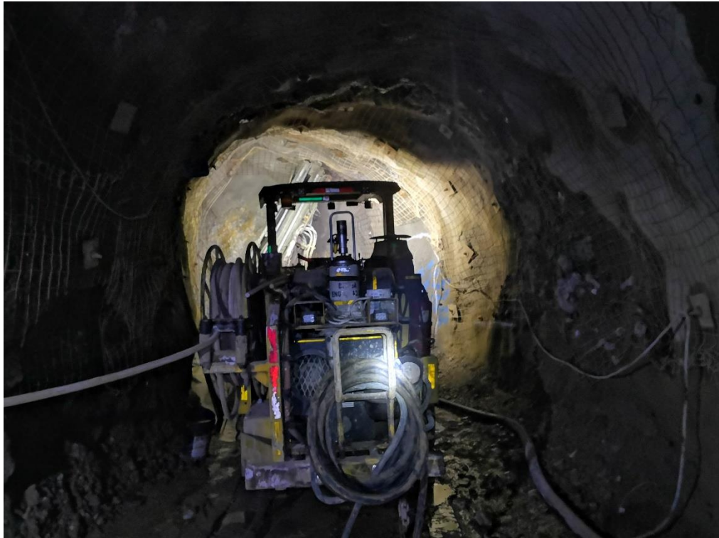
Figura 51. Equipos de Perforación en la Mina Yauricocha. Fuente: Elaboración Propia.
