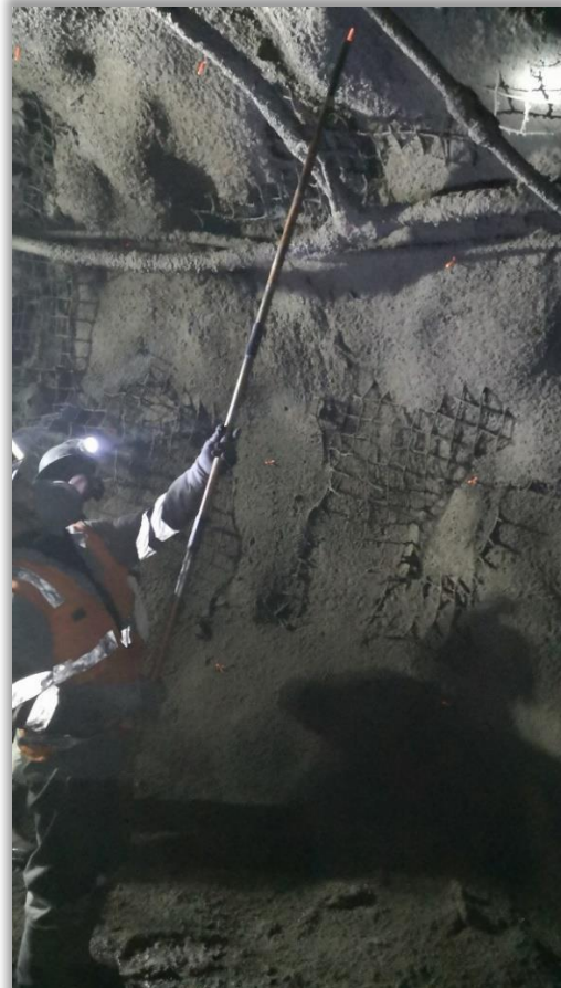
Figura 46. Trabajos de Sostenimiento en la Mina Yauricocha.
