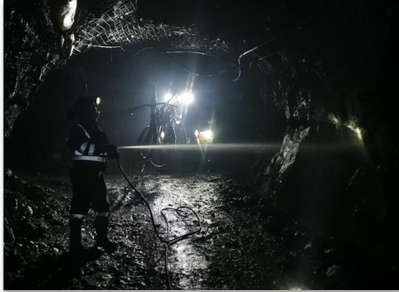
Figura 45. Sostenimiento de Labores Subterráneas Mediante el Concreto Lanzado en la Mina Yauricocha.
