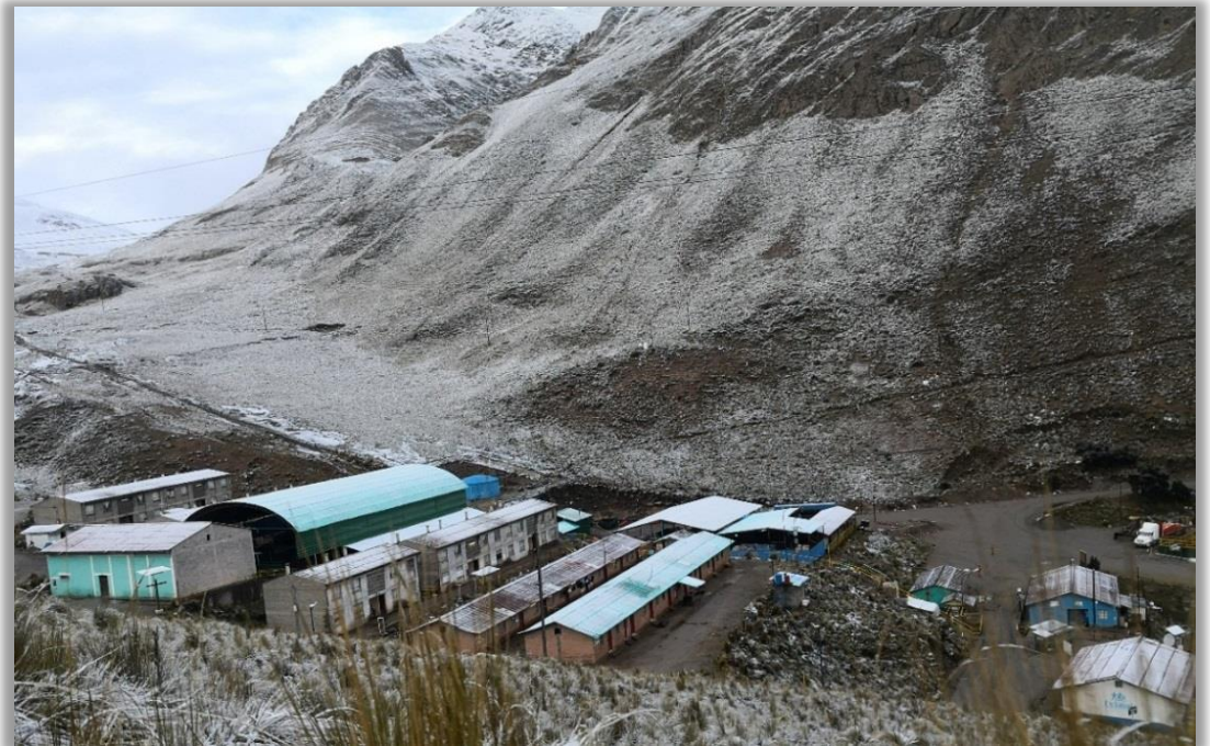
Figura 34. Campamento Chumpe de Sociedad Minera Corona S.A. Elaboración Propia.
