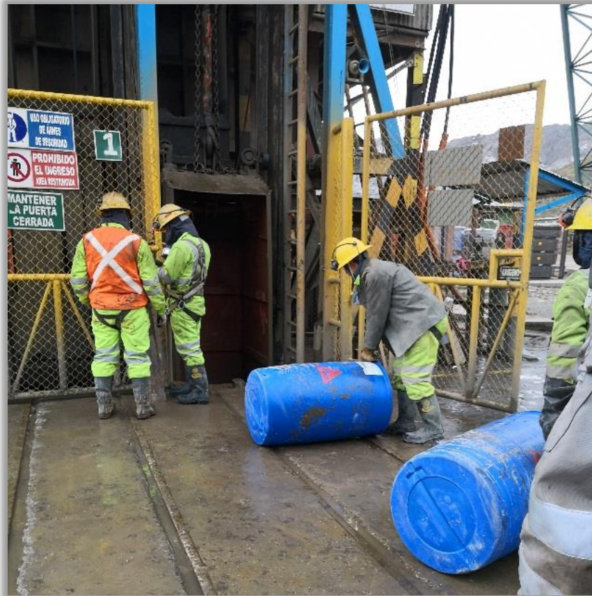
Figura 39. Manipulación de los Cilindros de Acelerante y Plastificante para ser Descendidos por el Pique.
