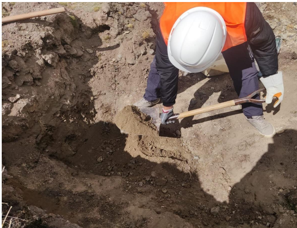
Excavación a cielo abierto de la Calicata N° 03 – 142 + 530.00 Km
