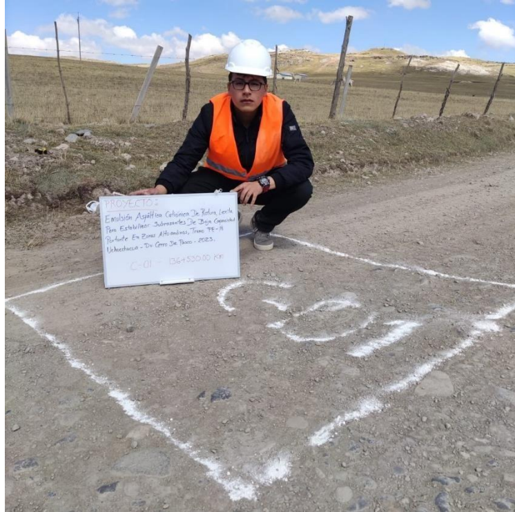
Ubicación de la Calicata N° 01 (Lado Izquierdo)
