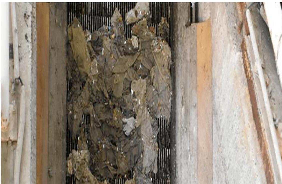
“Durante esta etapa, primero suele tener lugar un proceso de desbaste, donde se separan los residuos sólidos de gran y mediano tamaño mediante rejas y tamices de diferente grosor. Posteriormente, se retiran las grasas y las partículas de arena utilizando desarenadores-desengrasadores” (Idrica, 2022).
