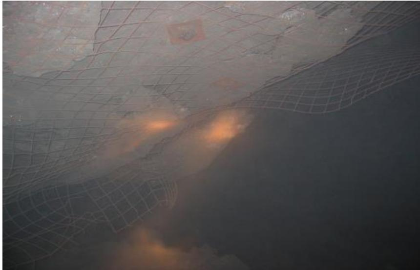
**Eyección de roca debido a la transferencia de energía sísmica (medio)**
