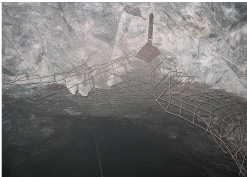
En esta fotografía se encuentra una mala instalación del perno split set, primera observación que está en el techo siendo esto colocado en cajas.
