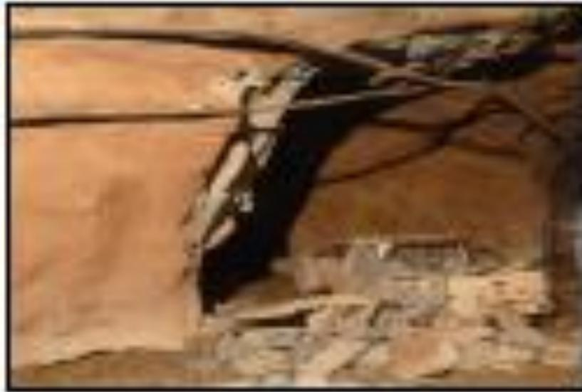
Figura N° 02: Muestra de Estallido de Roca
