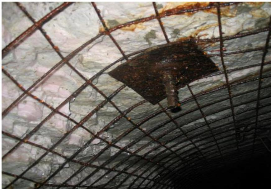
*Observando analíticamente notamos roca mármolizada que ofrece un sostenimiento natural, pero por seguridad se puede sostener.*
