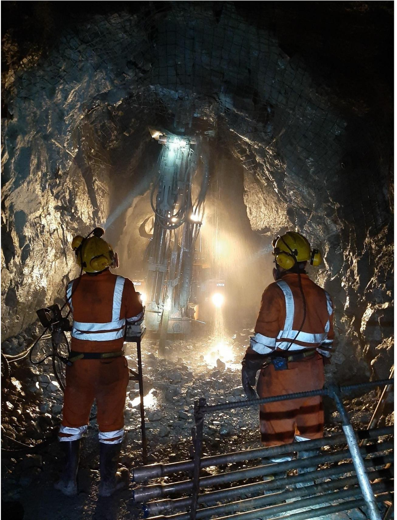
Foto N° 13. Perforación de veta coturcan techo para muestreo y voladura con taladros largos.
