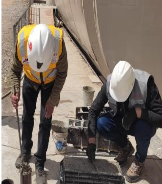
Se aprecia todos los testigos de concreto, tanto las probetas como las vigas.
