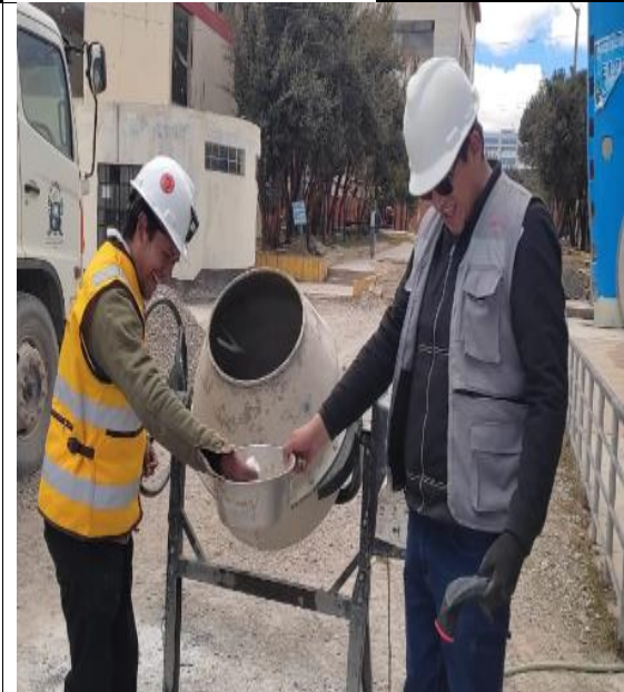
Dosificación de microfibras sintéticas en la mezcla.
