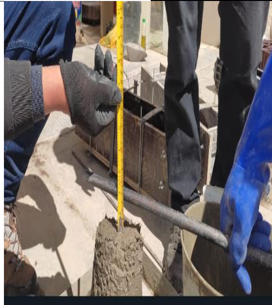
Toma de medida de SLUMP, teniéndose como máximo 4".
