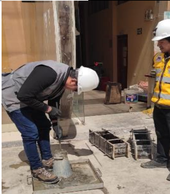
Verificación del SLUMP de concreto con el método de Cono de Abrams, verificándose que se tiene una medida máxima de 4".
