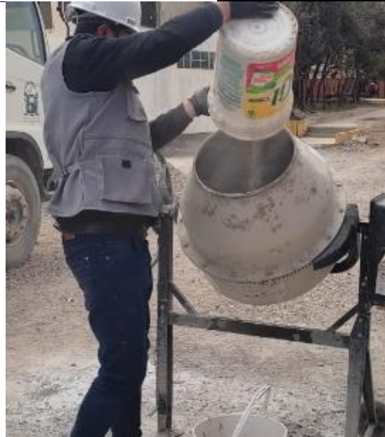
Proceso de mezcla con los insumos ya clasificados y pesados.
