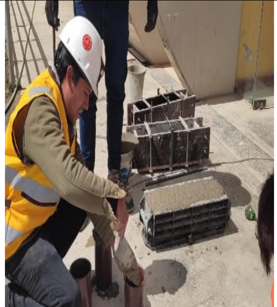
Proceso de realización de los testigos de concreto.
