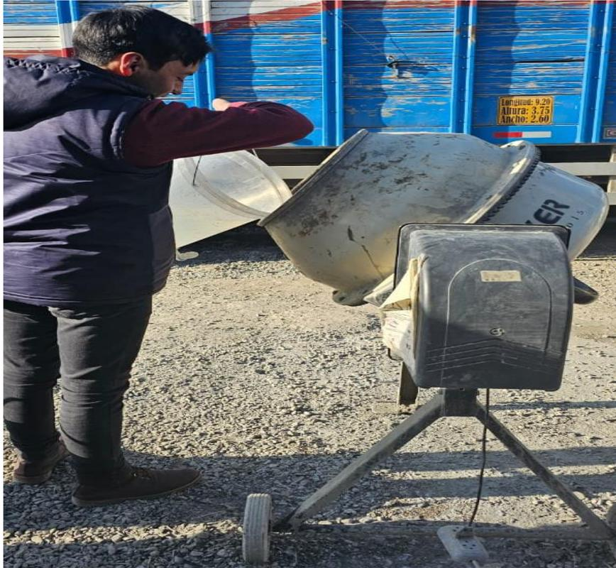
*Figura N°19: Llenado de agua en el Trompo Mezclador*
