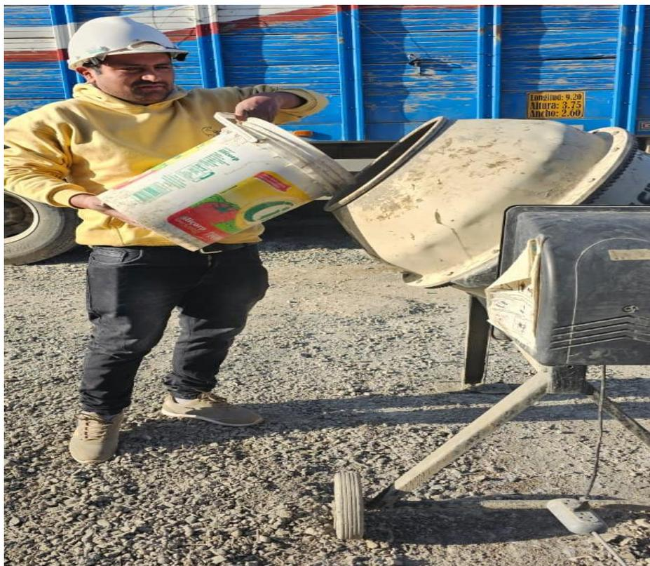
*Figura N°18: Llenado agregado en el Trompo Mezclador*
