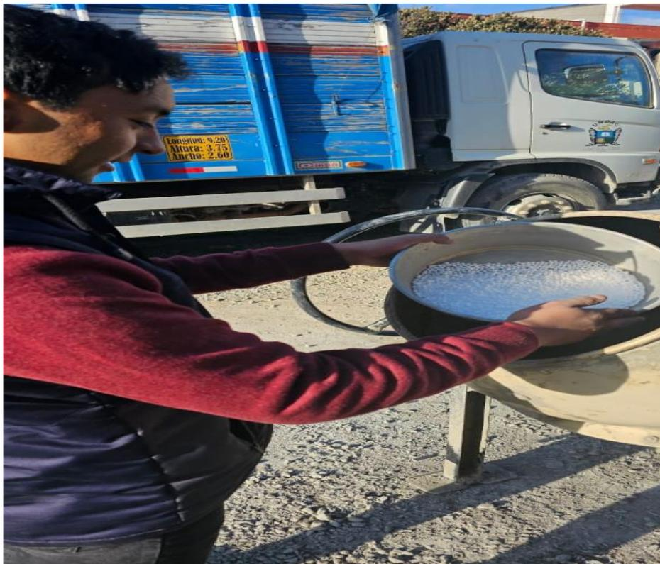
*Figura N°20: Llenado de perlas de poliestireno expandido en la mezcladora*
