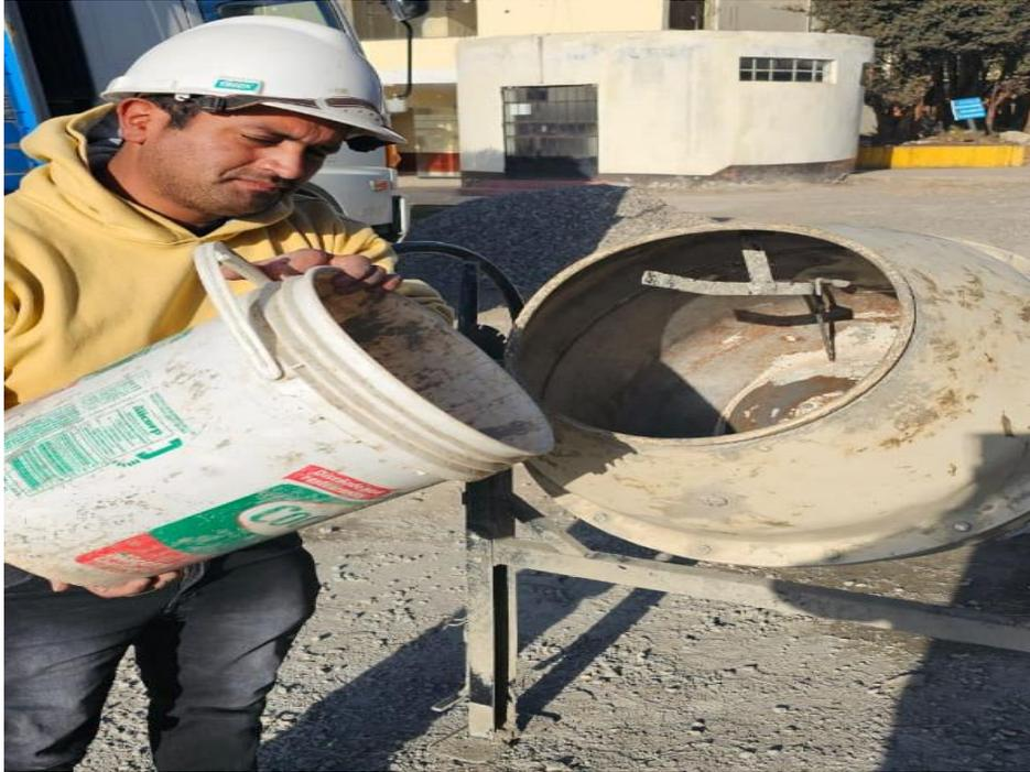
*Figura N°21: Llenado del cemento al trompo mezclador*
