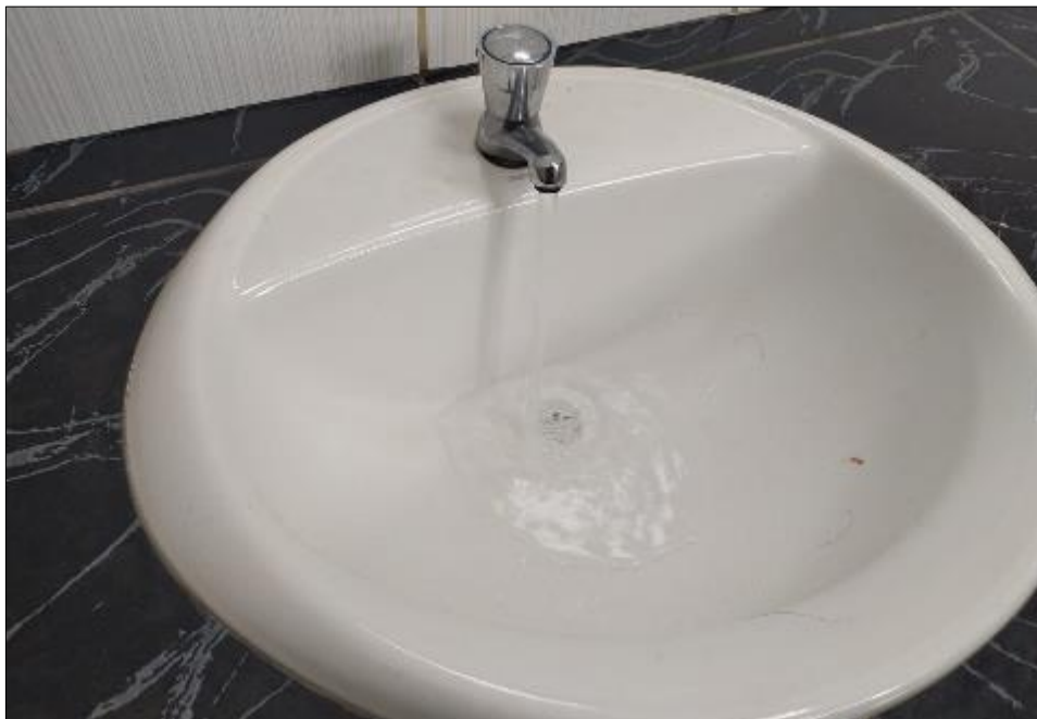
Fotografía 04.- Grifería de lavados existentes en la edificación
