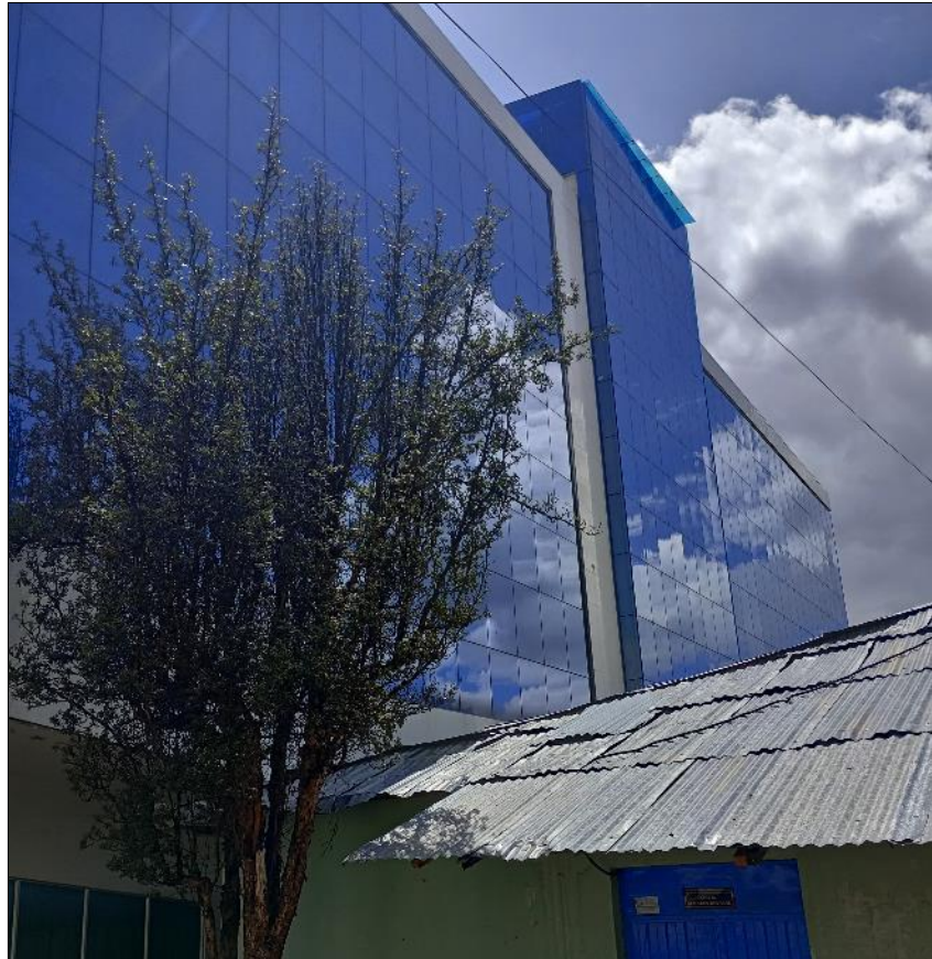
Fotografía 03.- Fachada lado Norte de la edificación
