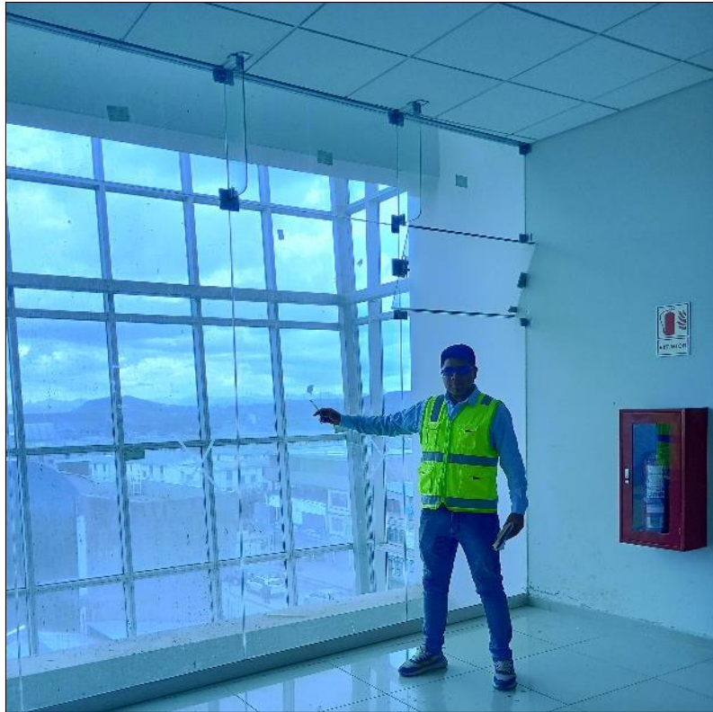
Fotografía 13.- Muros cortina de la edificación existente
