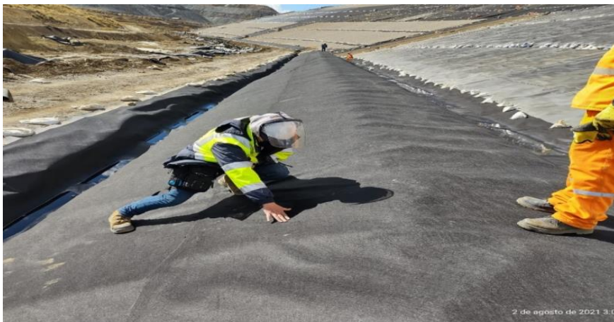
Fotografía 5: Colocación de geotextil en colchón reno.
