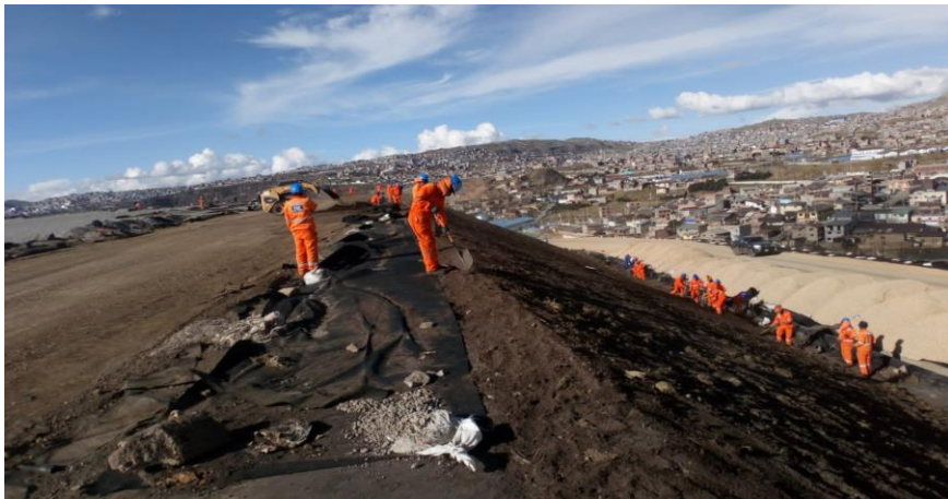
Fotografía 16: Tendido de top soil y excavación de zanja de anclaje
