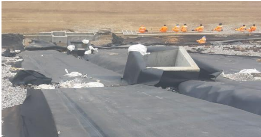
Fotografía 7: Cajas colectoras cubiertas con Geosintéticos
