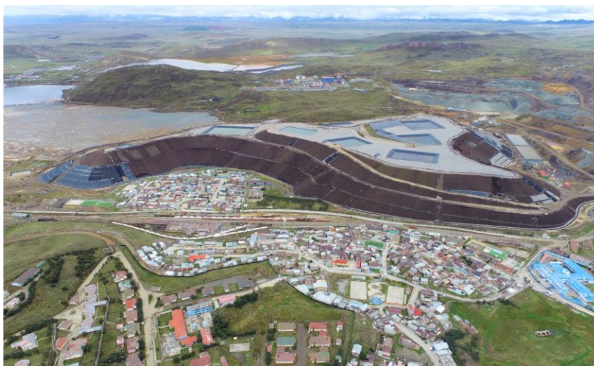
Fotografía 2: Panorámica del proyecto de remediación ambiental del Depósito de Desmontes Excélsior
