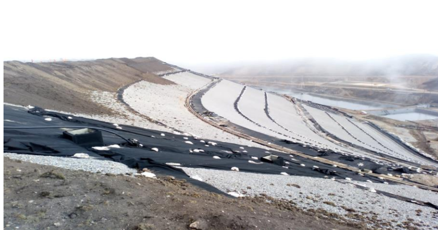
Fotografía 11: Vista de taludes del depósito de desmontes Excélsior
