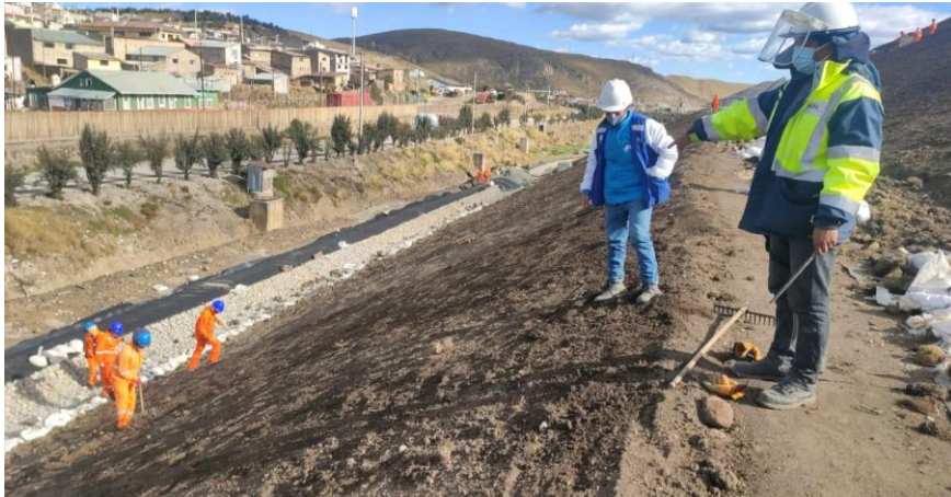
Fotografía 15: Tendido de top soil nivel 4320
