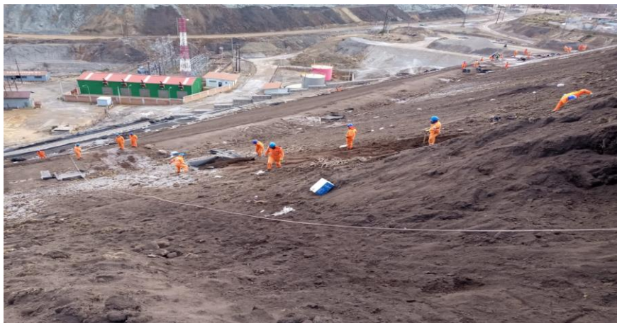
Fotografía 8: Tendido de Top Soil
