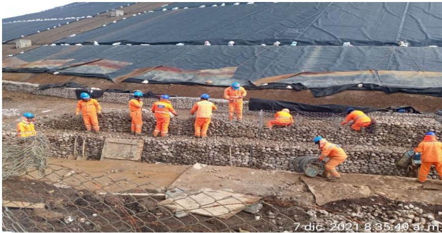
Fotografía 4: Construcción de gaviones de estabilidad
