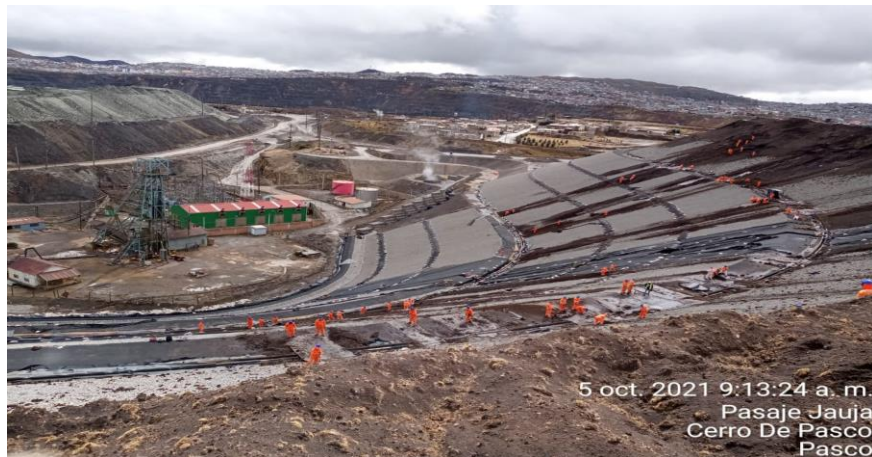
Fotografía 9: Retrabajos y limpieza
