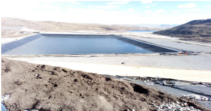
Fotografía 14: Impermeabilización de pozas con geomembrana
