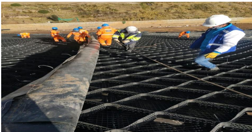
Fotografía 17: Tendido de top soil nivel 4320
