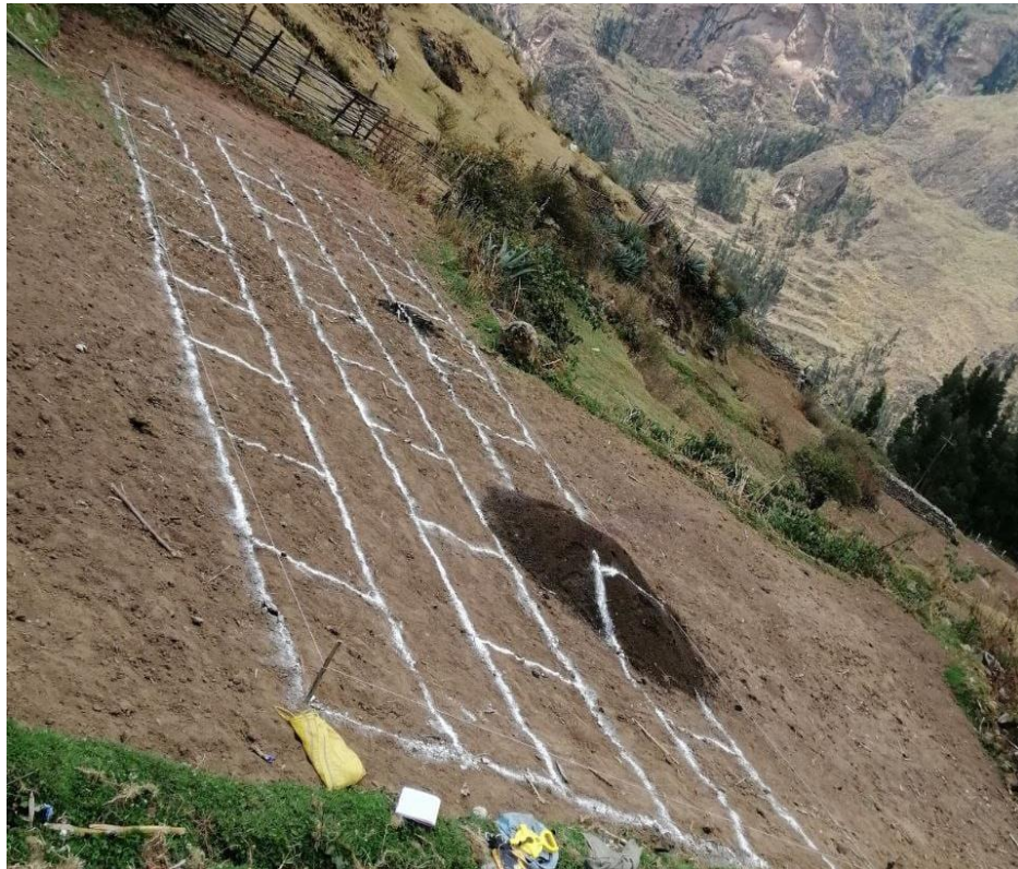
Preparación de terreno
