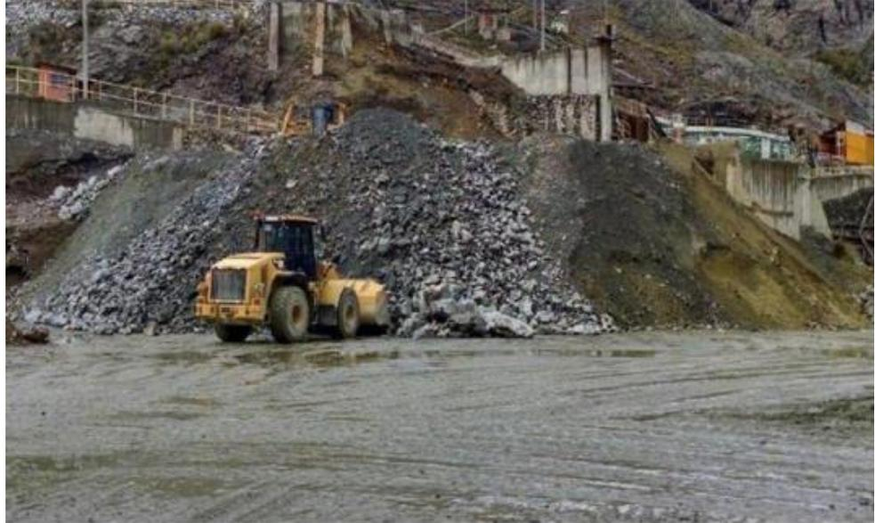
Nota. La imagen muestra el mezclado de stock pile
