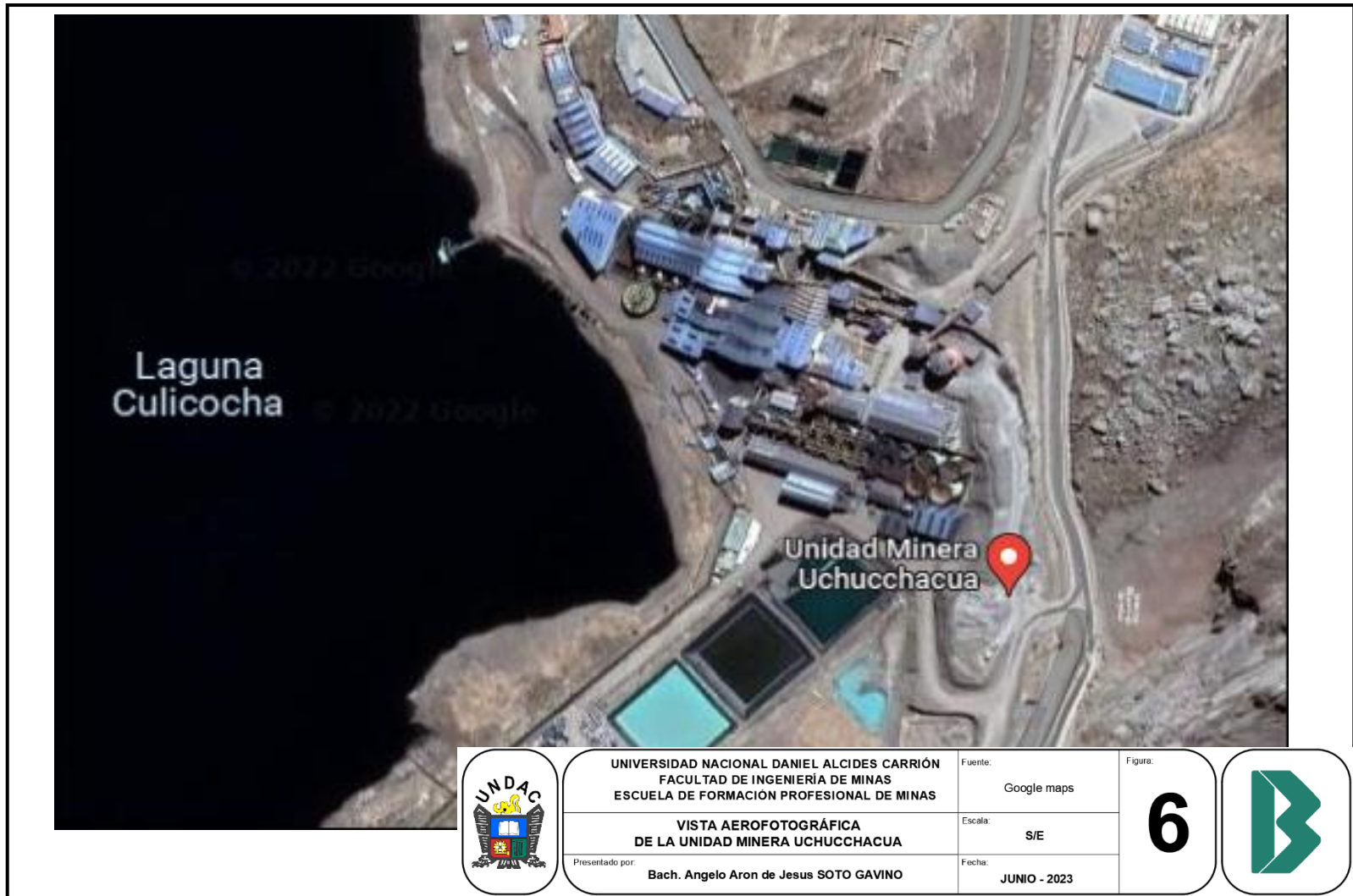
Figura 6. Vista aerofotográfica de la Unidad Minera Uchucchacua.
