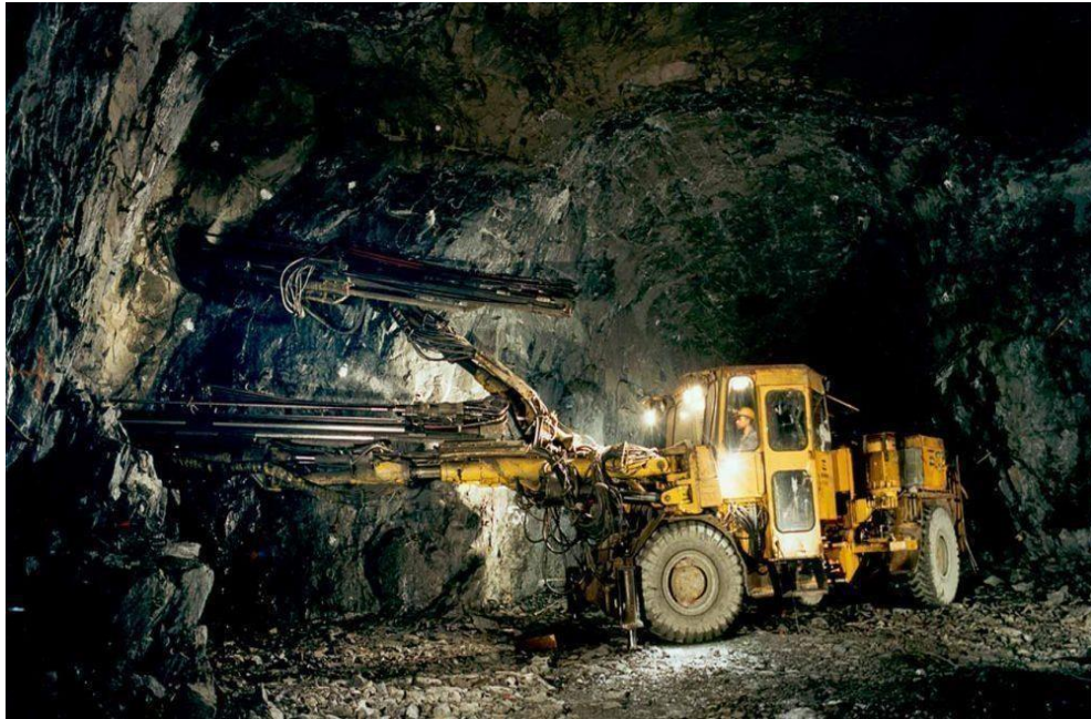
Figura 19. Perforación subterránea en Minería-
