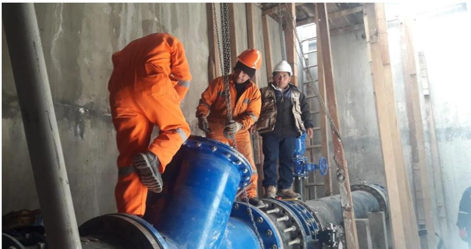
**En la siguiente imagen se puede apreciar la finalización de la instalación del filtro tipo YEE**
