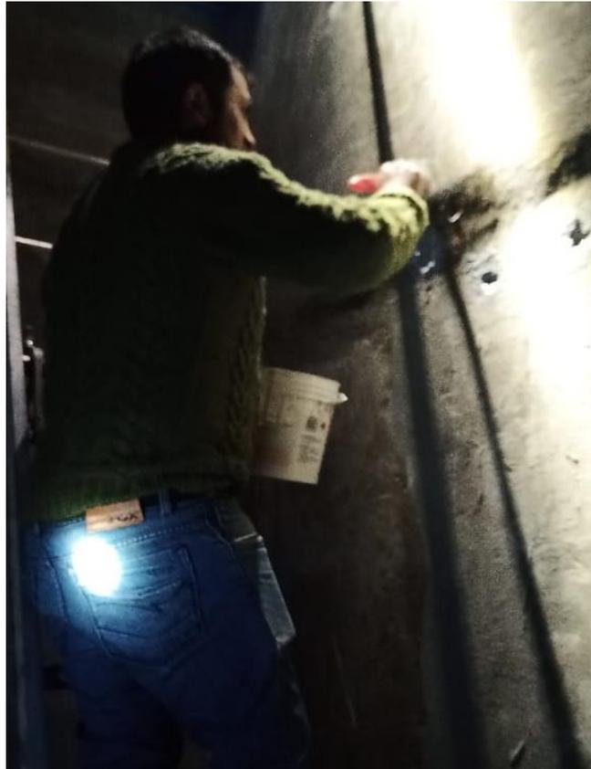
Anexo – Imagen N14 – Impermeabilización de la cámara de bombeo que no son atribuibles a uso de Water Stop
