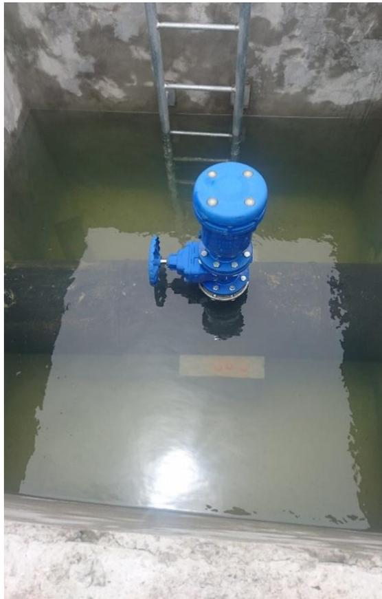
Anexo – Imagen N°02 Una cámara de aire diseñada y construida sin un sistema de contención de agua, conocido como "wáter stop", que garantiza la estanqueidad y la protección contra la infiltración de agua en su interior. Donde se observa que los accesorios de la cámara de aire están siendo dañados por la presencia de agua
