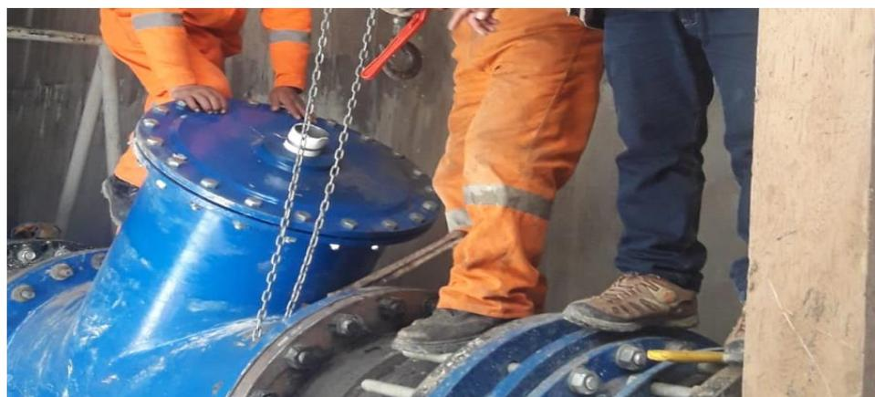
**En la siguiente imagen se muestra la instalación del filtro así como la válvula de purga del accesorio**
