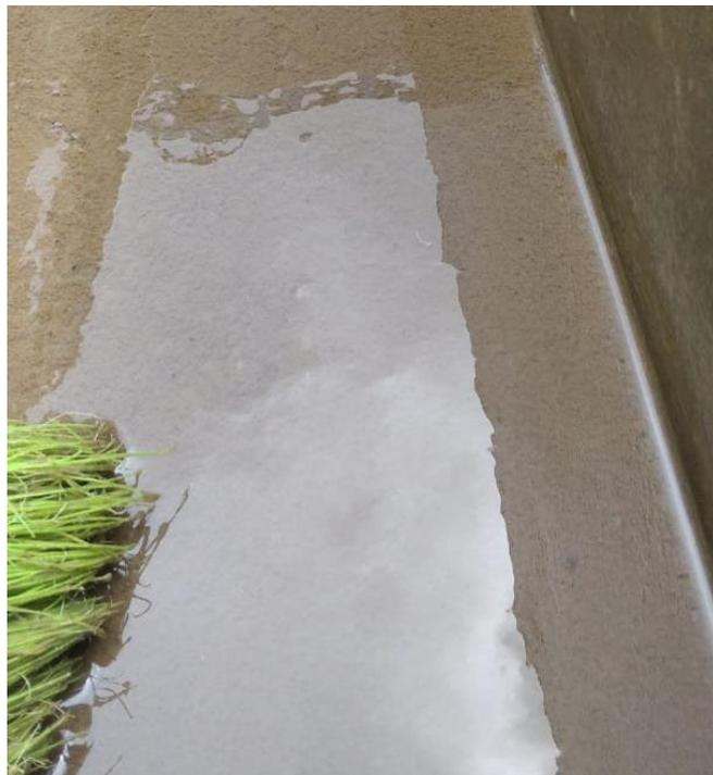
Anexo – Imagen N13 – Reservorio Lucerito con presencia de fuga de agua en la base del reservorio
