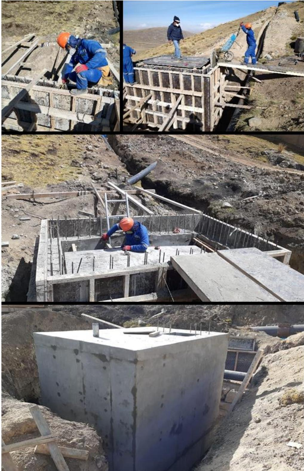
Anexo – Imagen N°05 – Estructuras de Concreto que a la fecha no han sufrido filtraciones de agua, debido al uso de Water Stop, en la unión de la base y la placa de la cámara de aire. Cabe señalar que no esta considerado en el diseño el uso de Water Stop, pero si es necesario para su funcionalidad
