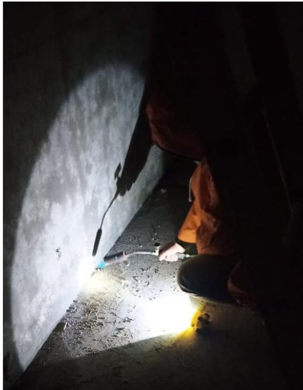
Anexo – Imagen N11 – Impermeabilización de la unión entre la base y la pared del reservorio Lucerito
