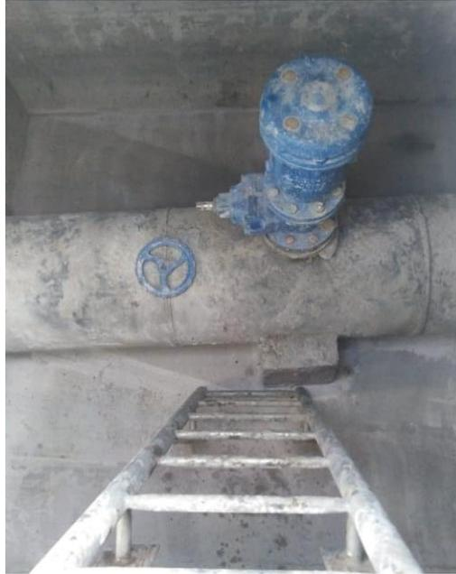
Anexo – Imagen N°03 - Cámara de aire construida con un sistema de contención de agua conocido como "wáter stop", que garantiza de manera efectiva la ausencia total de agua en su interior. Este ingenioso diseño y construcción con parada de agua asegura que la cámara de aire permanezca completamente seca, sin ningún rastro de humedad ni presencia de agua.
