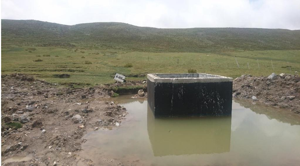
Anexo – Imagen N°01 - Cámara de aire construida donde existe presencia de agua al exterior de la cámara, en la que se ha diseñado sin necesidad de utilizar un sistema de detención de agua.
