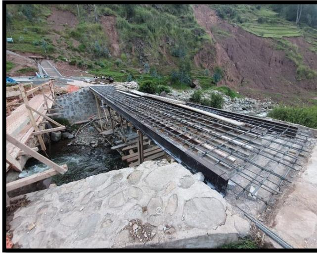
*Nota.* La figura muestra la armadura del puente en el km 0+050 se muestra los estribos, vigas, etc.Fuente: Elaboracion propia.
