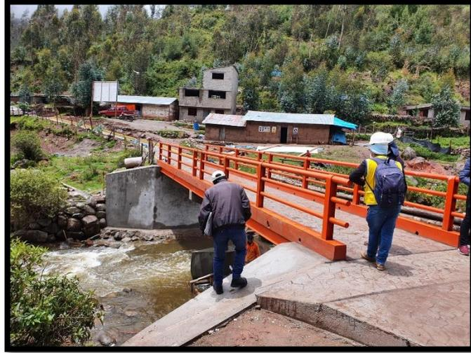
*Nota.* La figura muestra el puente concluido en el km 0+050 se muestra los estribos, vigas, barandas, juntas de dilatacion, etc.Fuente: Elaboracion propia.
