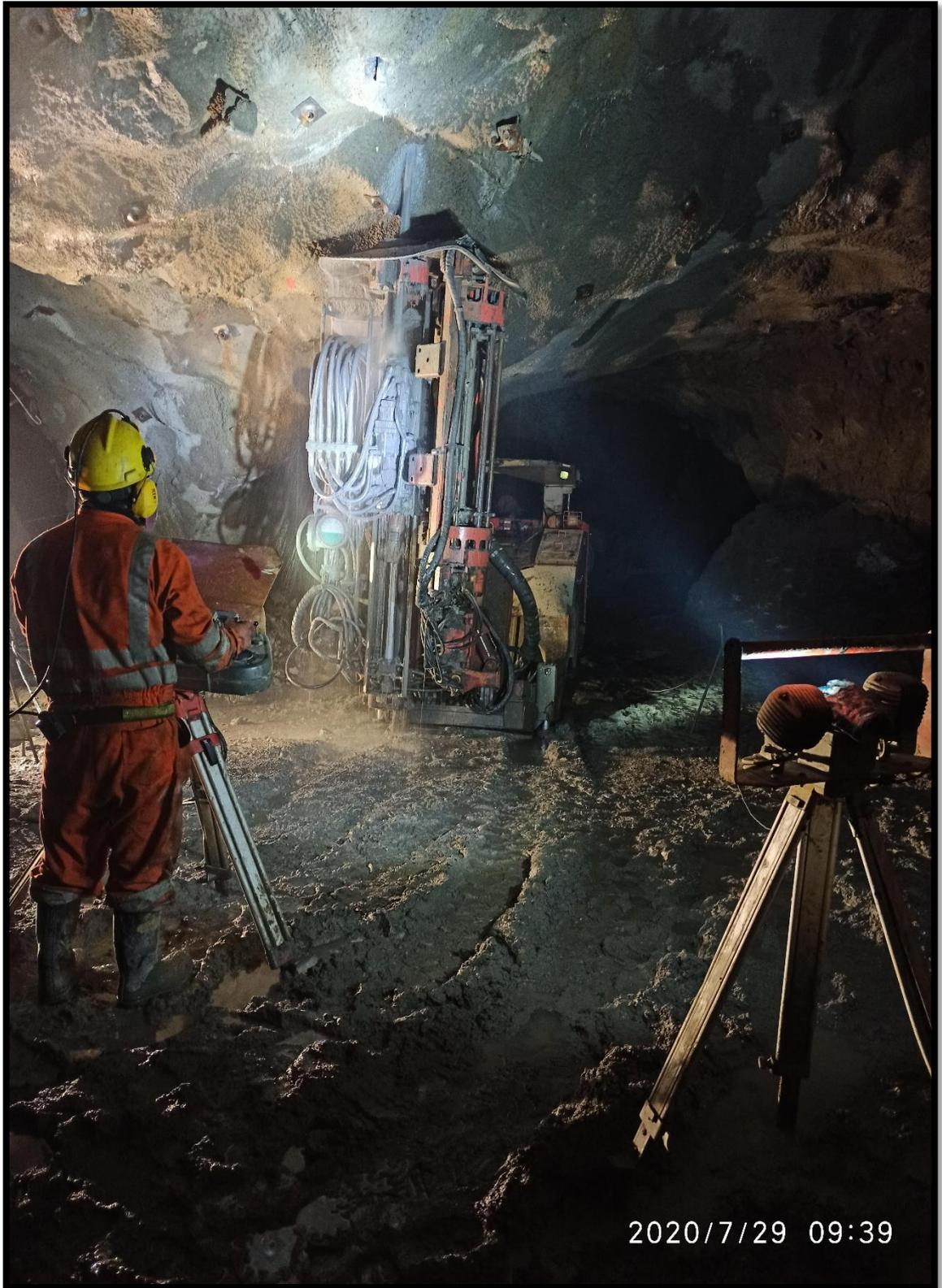
*Fotografía N°3: Perforación de taladros largos en abanico con equipo SIMBA,*
