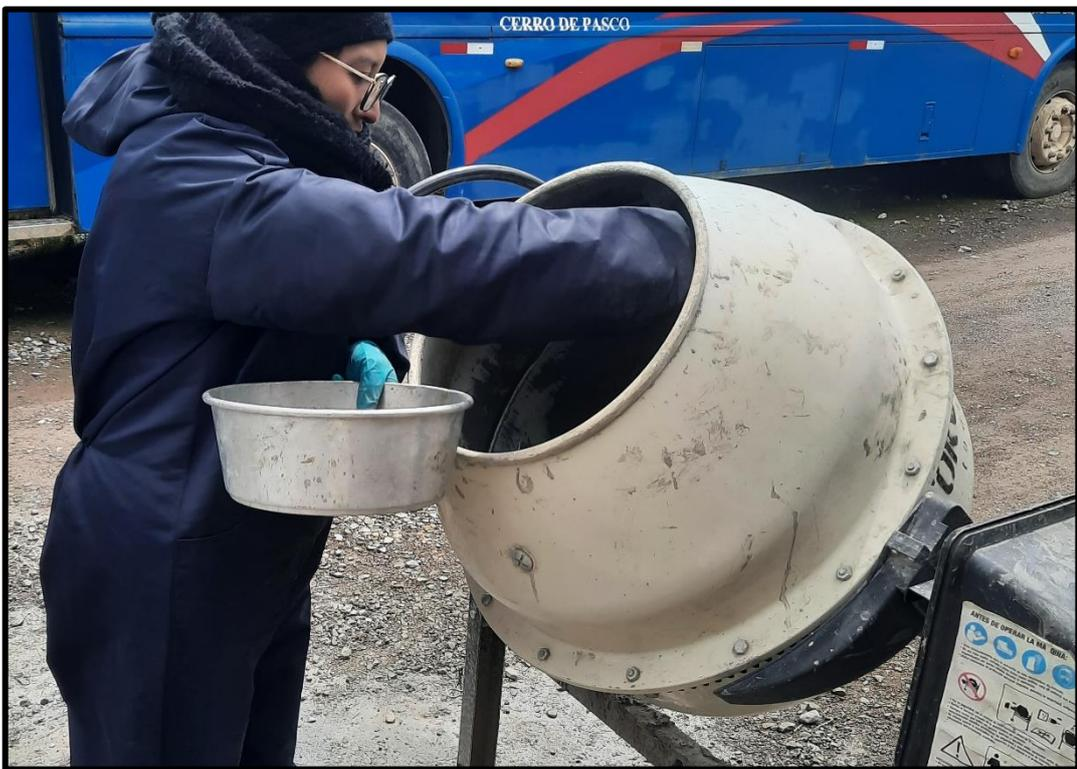
**Fotografía 12.** Echado de los materiales a la mezcladora del concreto.
