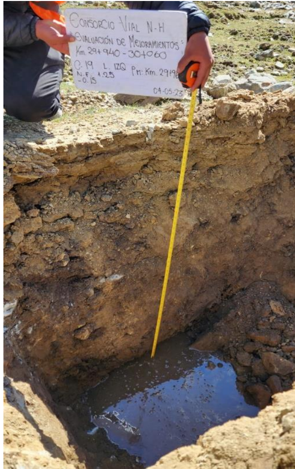
Ilustración 2: ejecución de las calicatas para evaluación del suelo de fundación (Fuente: CNH)
