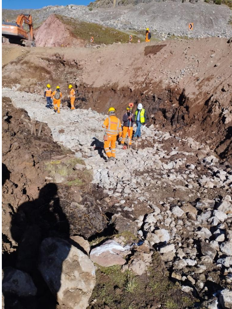
Ilustración 7: Mejoramiento de los Suelos para conformación de subrasante (Fuente: Propio)
