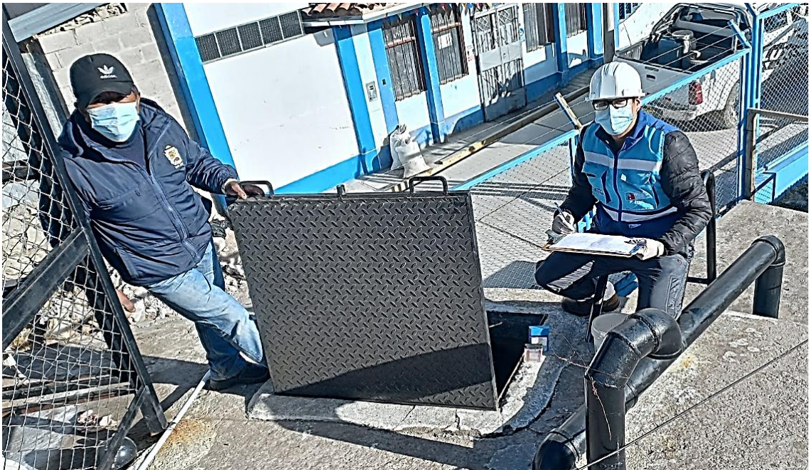
Verificación de reservorios
