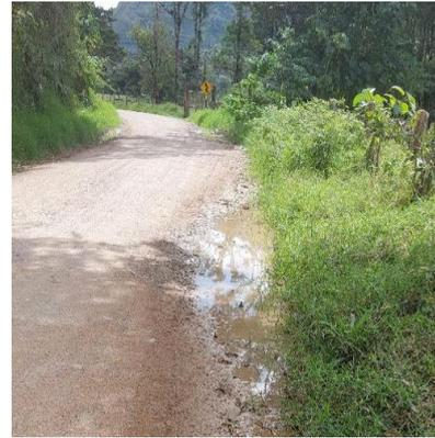
**Fotografía N° 08.** Tramo de vía con afirmado en deterioro y cuneta colmatada
