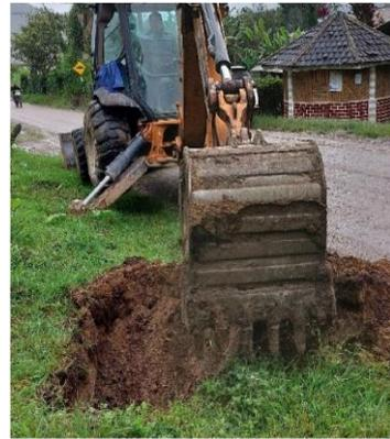
**Fotografía N° 16.** Excavación de calicata en la CC.NN de Tsachopen.
