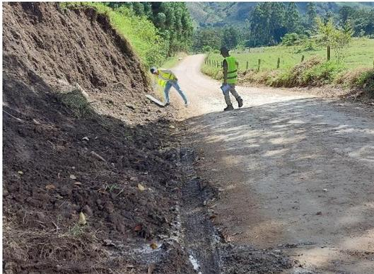
**Fotografía N° 11.** Deslizamiento de talud y afirmado en pésimo estado de la vía en estudio.
