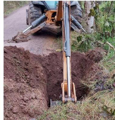
**Fotografía N° 12.** Excavación de calicata al costado de la vía.
