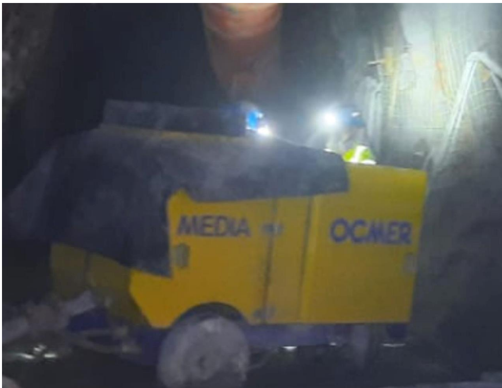
Figura 66. Trabajos de sostenimiento.
