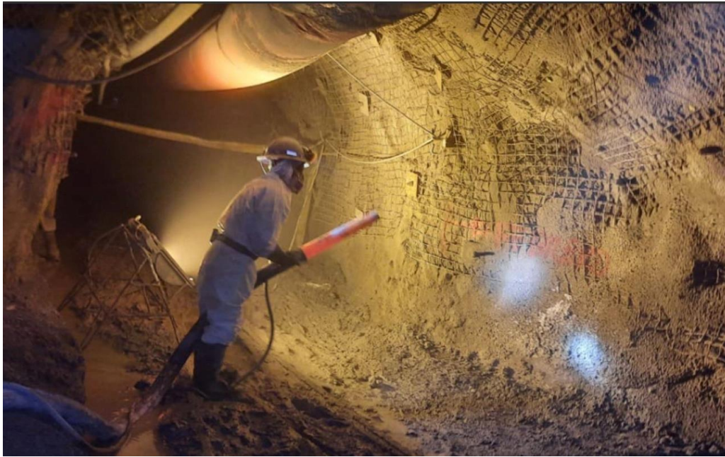
Figura 65. Sostenimiento de labores subterráneas.
