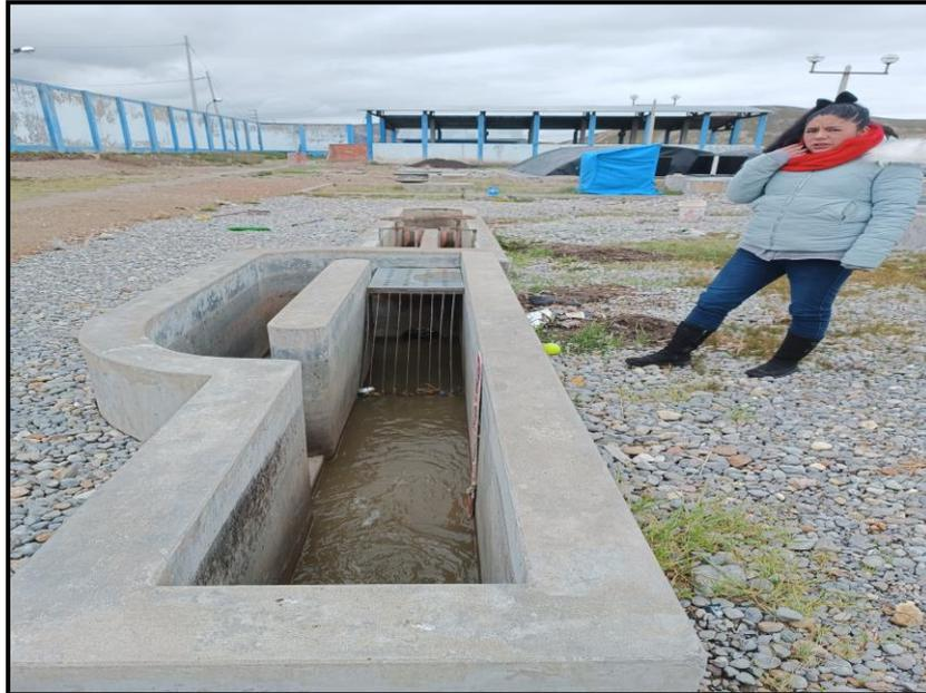
**b. Desarenador – medidor parshall**
