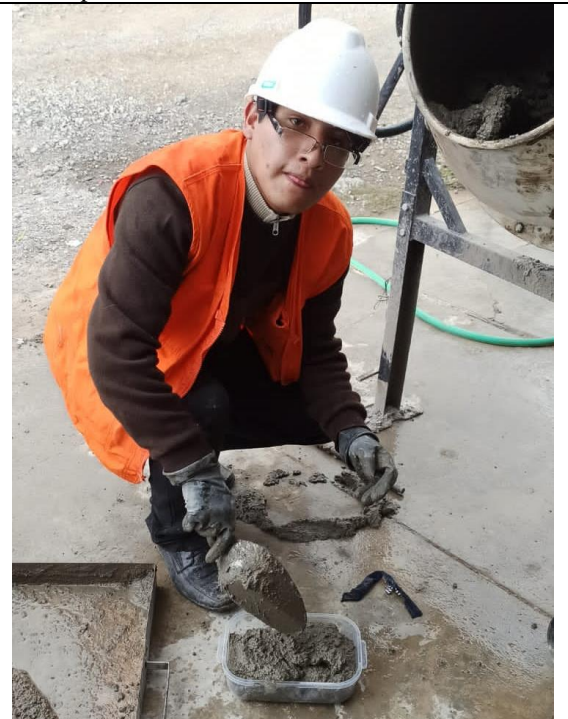
Foto N°16: Toma de muestras en moldes para realizar ensayos de resistencias tempranas en fraguado.
