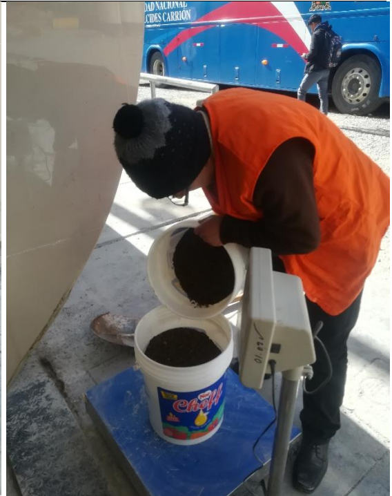
Foto N°02: Peso de Arena de Gradación N°02 según dosificación para mezclado.
