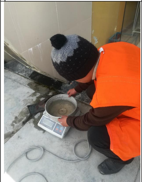
Foto N°03: Peso de agua según dosificación para mezclado.
