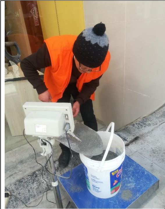
Foto N°01: Peso de cemento según dosificación para mezclado.
