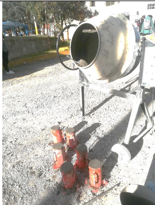
Foto N°15: Probetas cilíndricas con concreto para ensayos de resistencia a la compresión.
