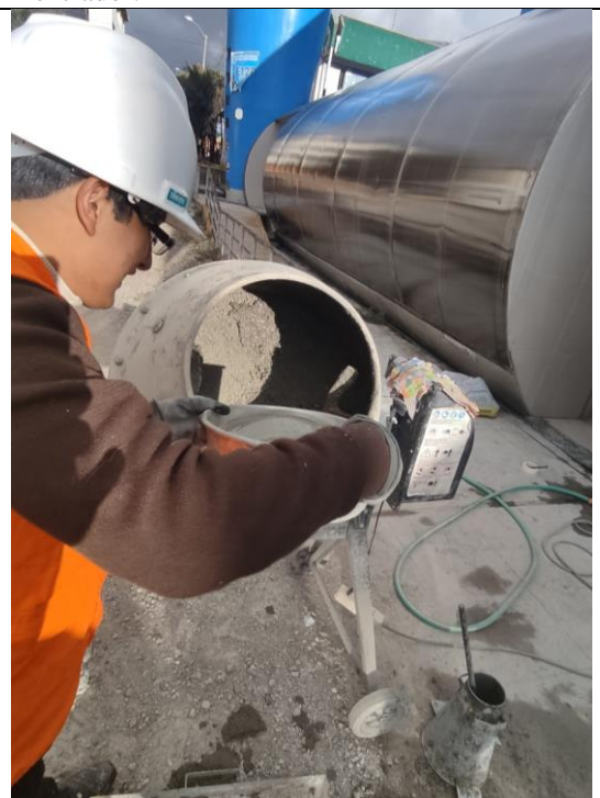
Foto N°08: Adición de materiales en el trompo mezclador.
