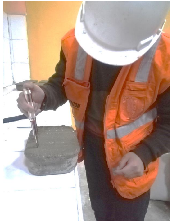
Foto N°20: Medición de resistencias tempranas con penetrómetro en las muestras obtenidas.
