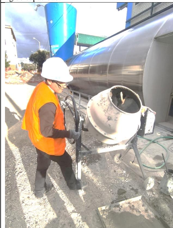
Foto N°07: Inicio de mezclado de materiales dosificados en el trompo.
