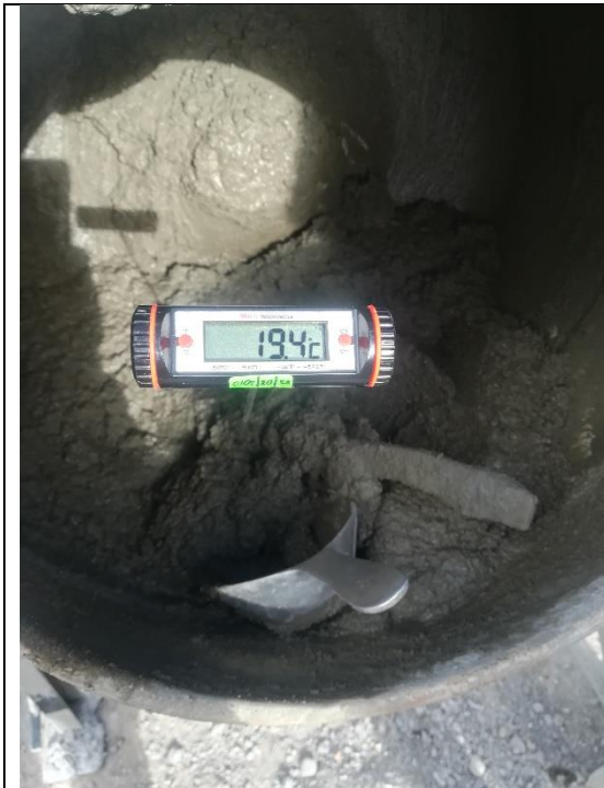
Foto N°13: Medición de temperatura en la mezcla de concreto fresco.
