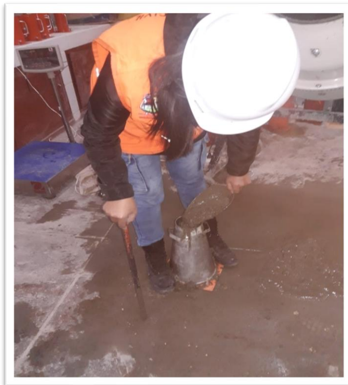
FOTOGRAFÍA 16: Medición de consistencia del concreto fresco por el método de cono de Abrams.
