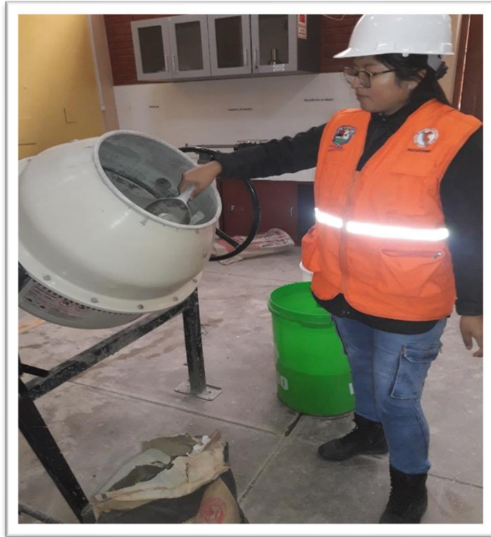
FOTOGRAFÍA 13: Mezcla del concreto con dosificaciones de Macrofibra y Antisalitre.
