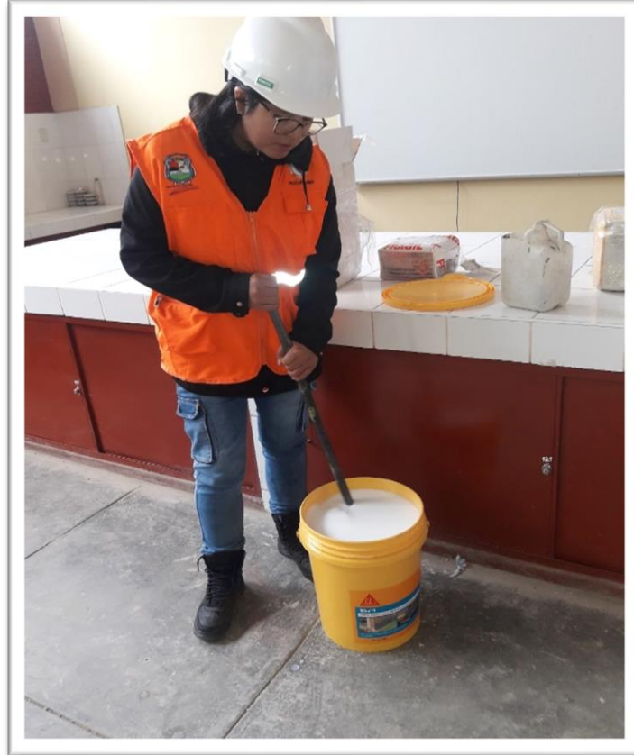
FOTOGRAFÍA 11: dosificación de Antisalitre.
