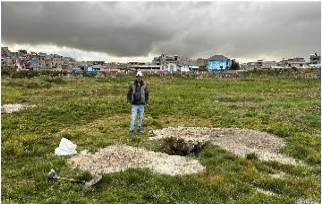
Fotografía N°02.- Extracción de muestra de la Calicata N°01 de la zona Chaquicocha, para conocer las propiedades físicas y mecánicas de suelos.
