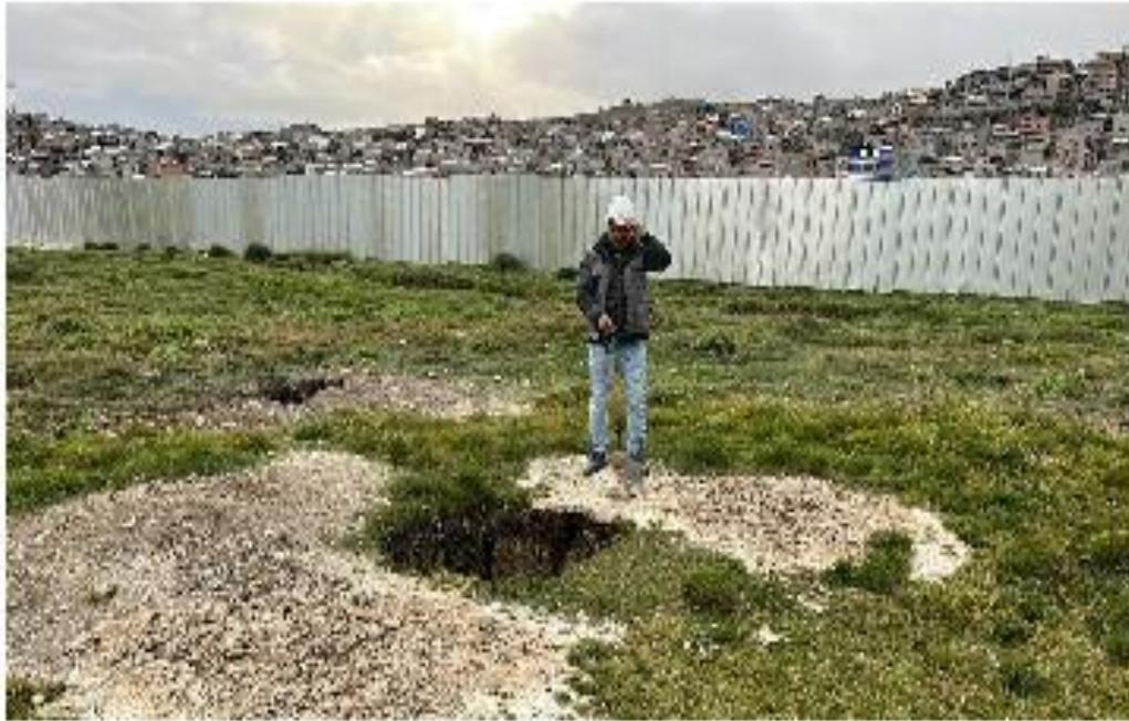
**Fotografía N°07.- Extracción de muestra de la Calicata N°02 de la zona Chaquicocha, para conocer las propiedades físicas y mecánicas de suelos.**
