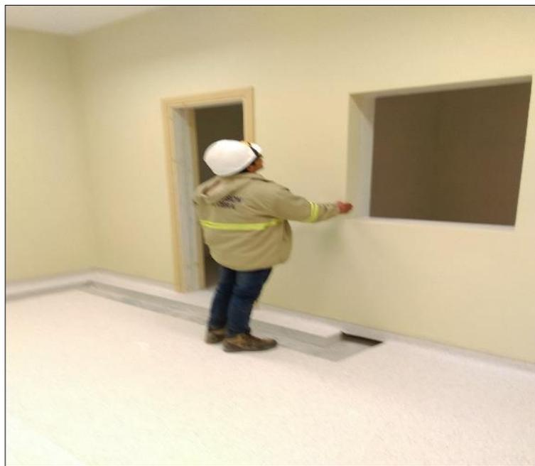
*Figura 38. Tarrajeo final de las paredes piso y cielo raso.*
