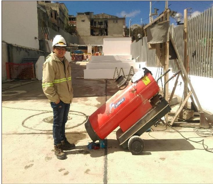
*Figura 37. Cañón de calor a emplear para el control de temperatura ambiente*
