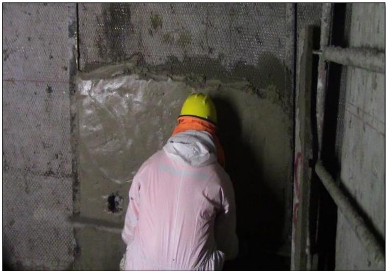
*Figura 21. Colocación de muestra alisada y dejada para fraguar*
