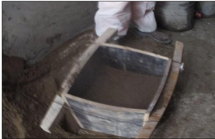
*Figura 13. Pie cubico utilizado en obra para dosificar*
