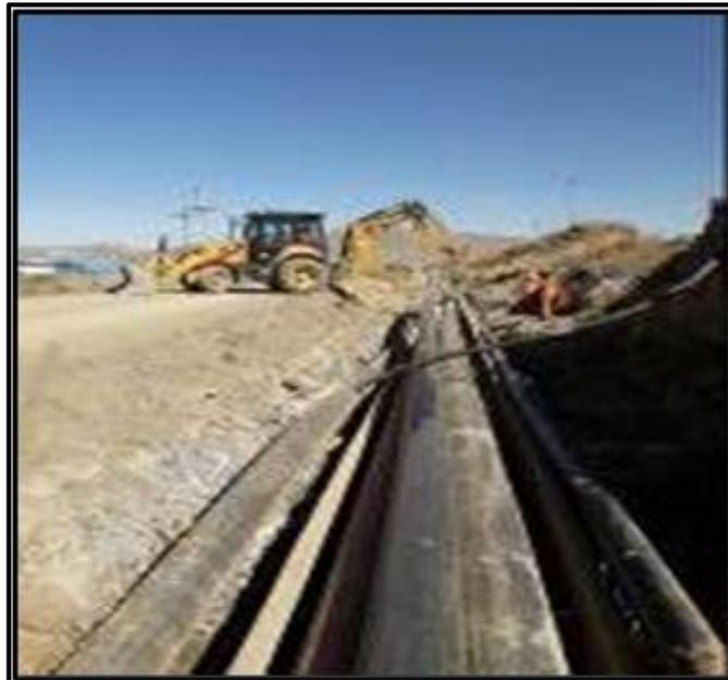
*Movimiento de línea de tubería con retroexcavadora*
