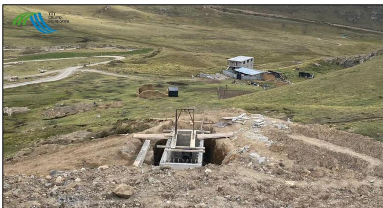
IMAGEN 4: LLEGADA DE LÍNEA DE CONDUCCIÓN / FUENTE: PROPIA
