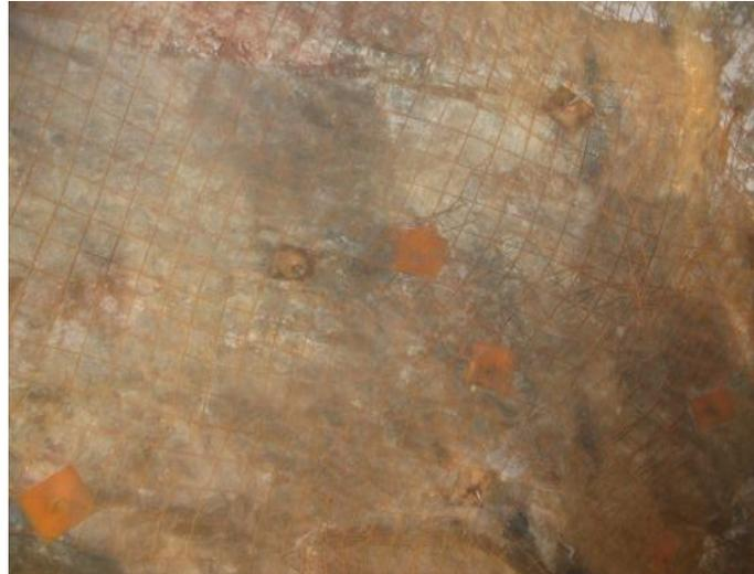
**Perno split Set en tajo bien instalado y trabando sobre terreno brechoso**
