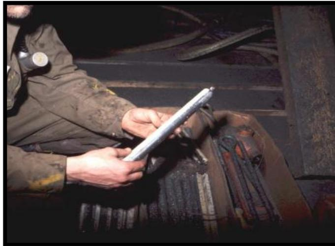
En la barra de perforación de siete pies se viene instalando en el momento 5 cartuchos de resina para mejor rendimiento del sostenimiento, estos son batidos con el adaptador en el momento de ingreso después de colocados las resinas y batidos por dos minutos hasta completar el ingreso de resina a todos las oquedades y el fraguado necesario.
