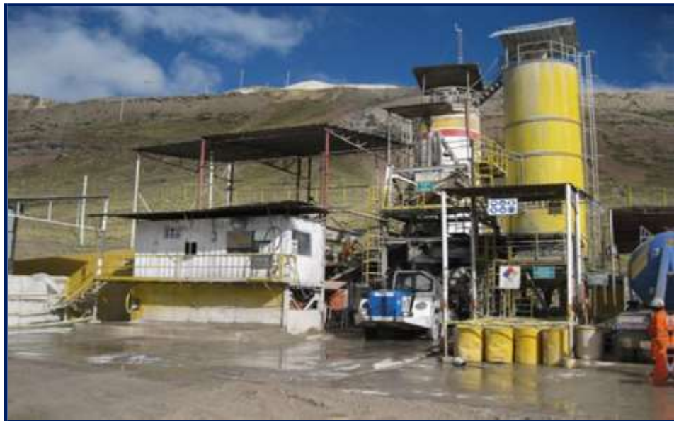
Figura 32. Planta de concreto. U.E. Animón. Fuente: Bardales, J. Aldave, E.. Dpto. Geomecanica. U.E. Animón.
