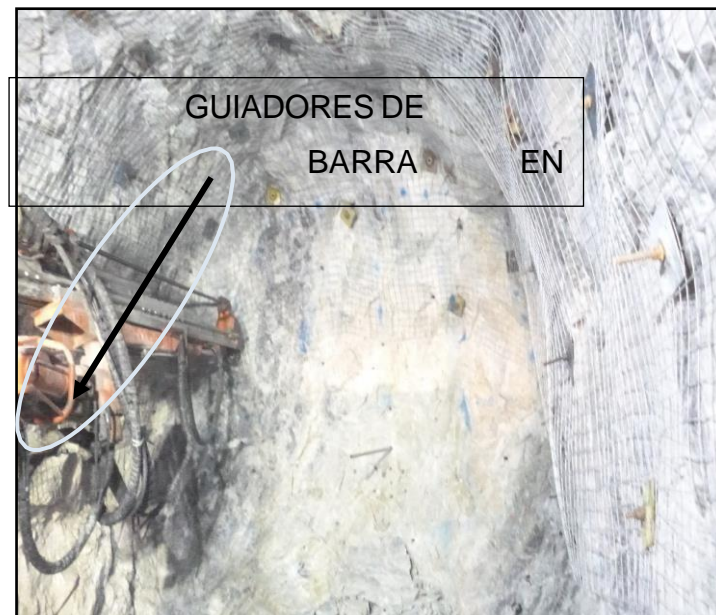
Figura 17 Perforación con guidores.
