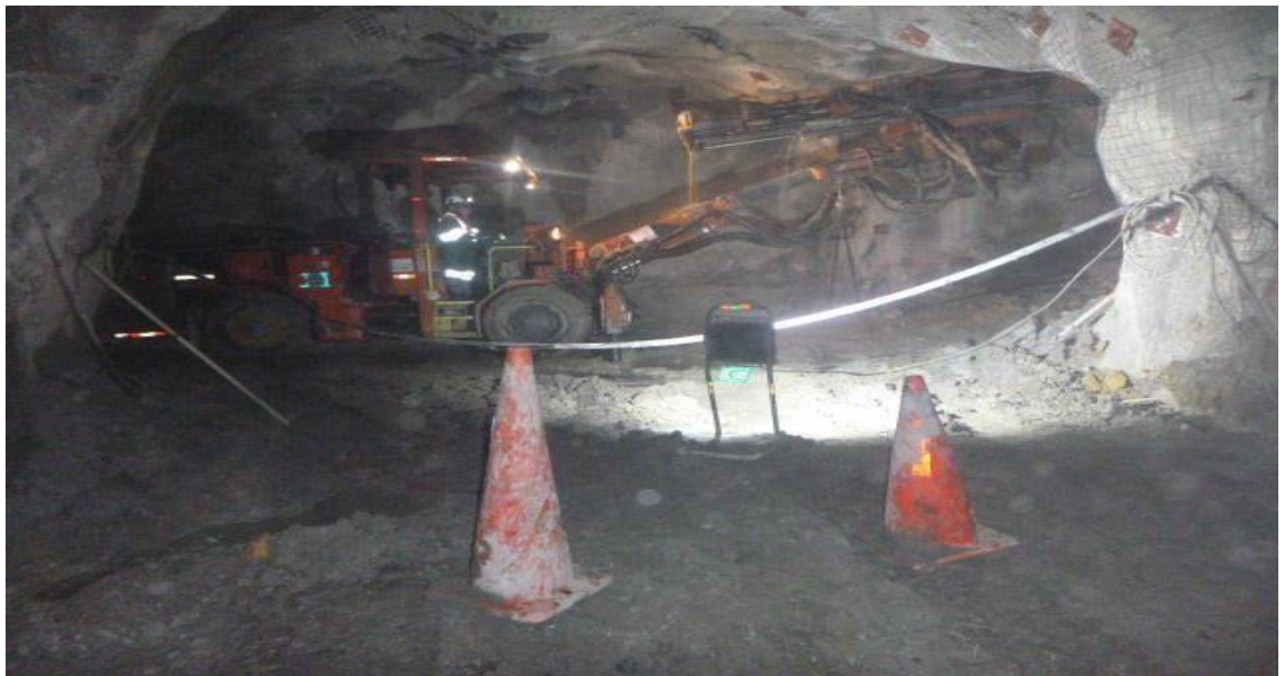
Figura 90 Frente de perforación con Jumbo de 1 brazo.
