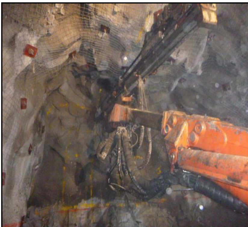
Figura 18 Perforación direccionada con la cola.
