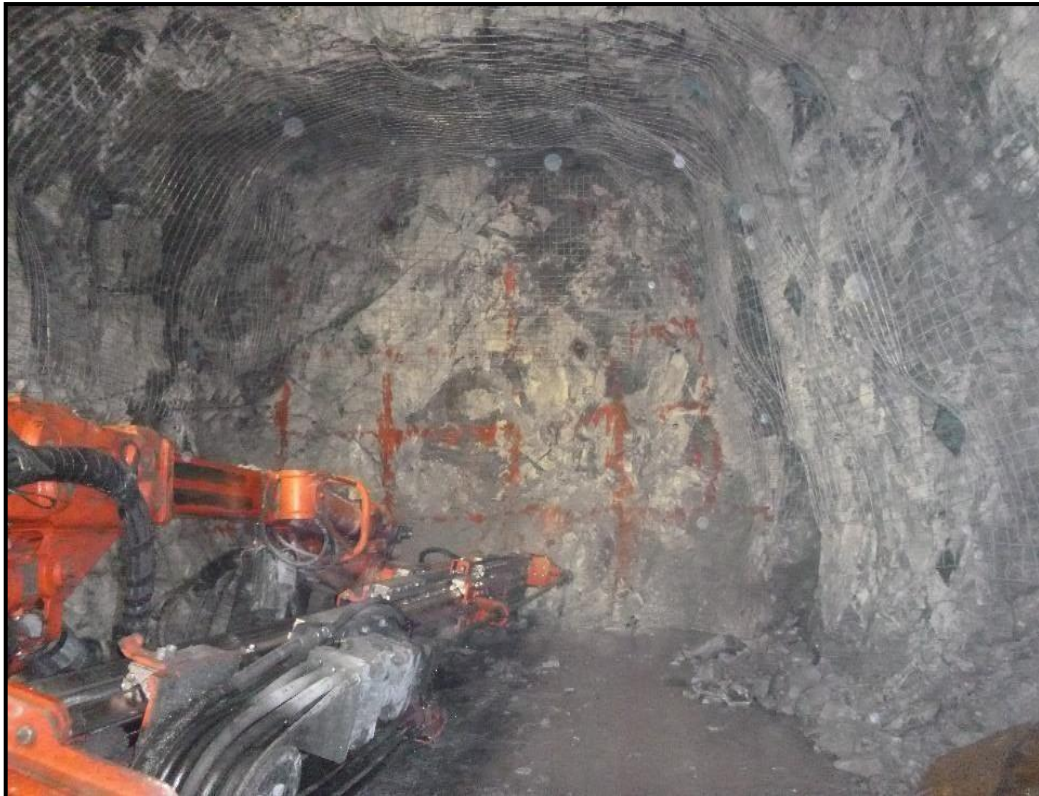
Figura 13 Pintado de malla de perforación. Fuente: Elaboración propia.
