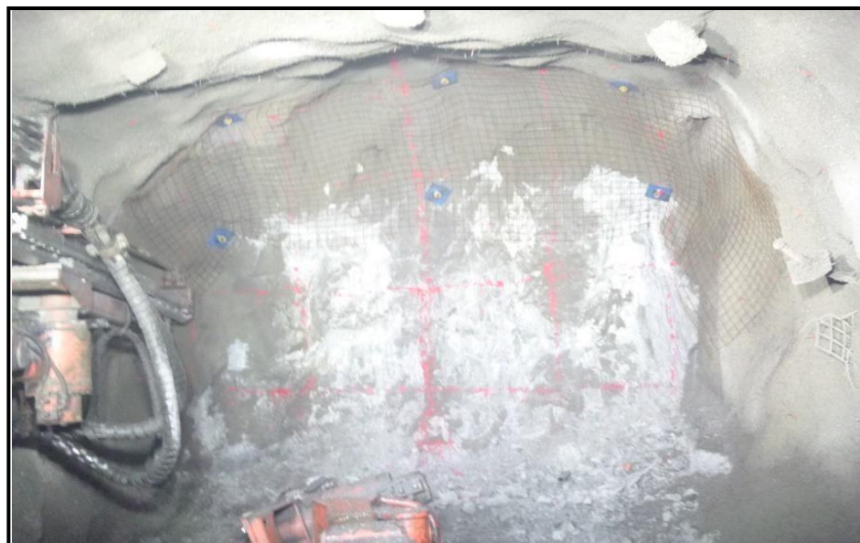
Figura 15 Pintado de malla de perforación.
