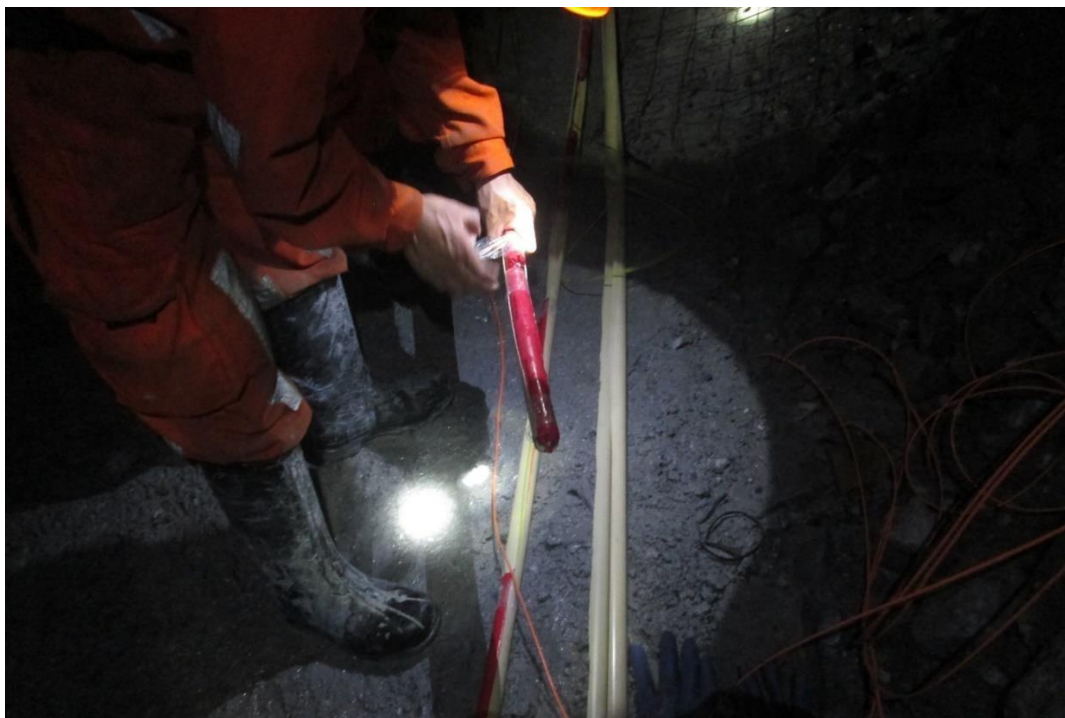
Figura 94 Armado de caña para voladura controlada.
