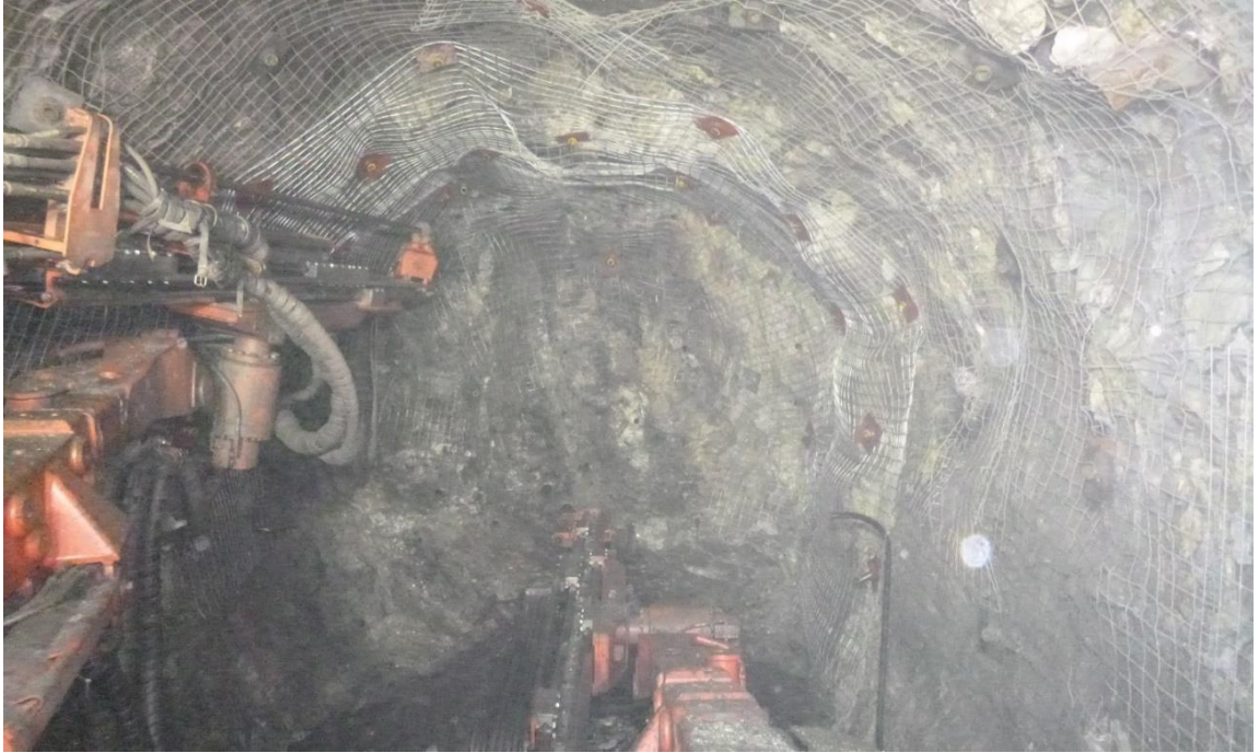
Figura 89 Frente de perforación con Jumbo de 2 brazos.
