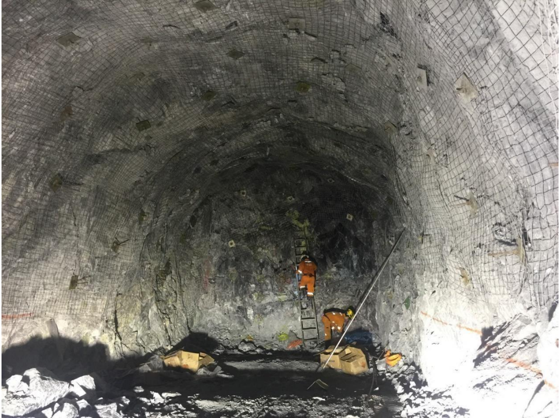
Figura 95 Carguío de frente de la Rpa 944.
