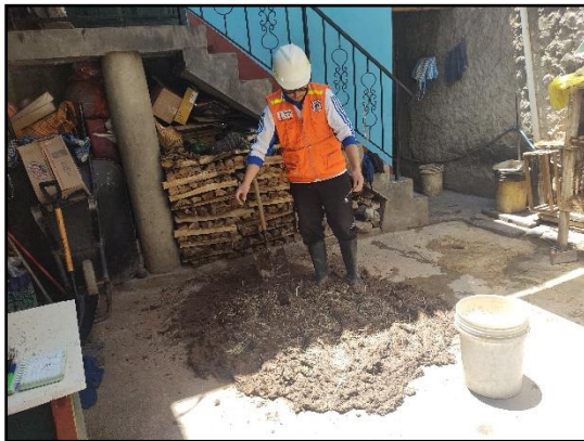
7. Surtido de la paja de 5cm de longitud en toda la mezcla, distribuyéndola homogéneamente.
