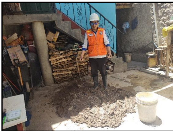
Fotografía: Mezclado del barro con paja y la culminación del proceso de fabricación de las unidades de adobe con paja (muestras de control).
