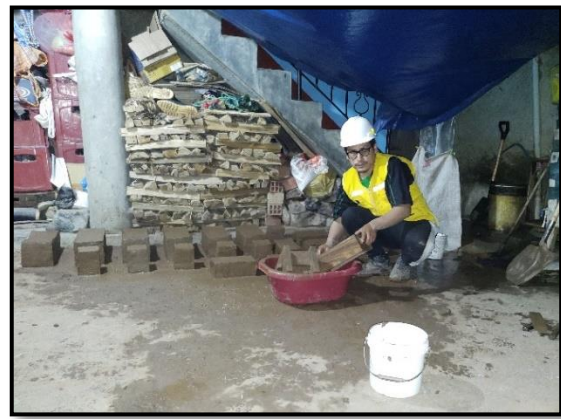
Fotografía: Mezclado del barro con adición de 0.27% de fibras y 50% de extracto de maguey y su posterior proceso de fabricación de las unidades de adobe.
