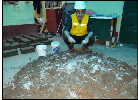
Fotografía: Mezclado de extracto y fibras de maguey con el suelo.
