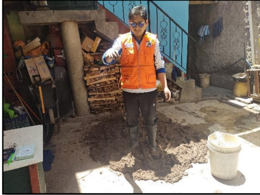
5. Comprobación del contenido de humedad mínima para la mezcla.
