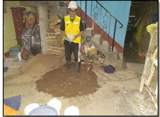
4. Adición de fibras de maguey cortadas cada 5cm de acuerdo a la proporción de la tabla 36.
