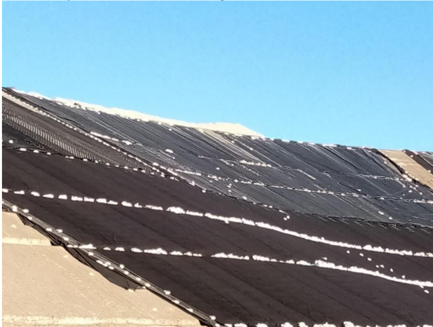
Figura 1. Vista suroeste del Depósito de Desmontes Excélsior
