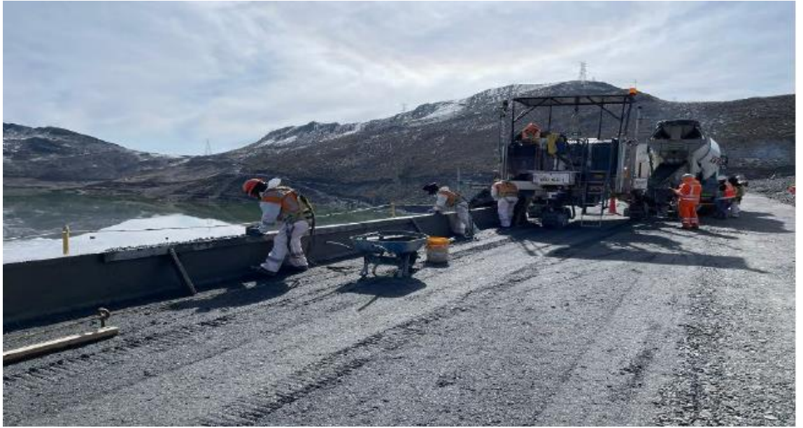
Fotografía: Solaqueo de concreto curb
