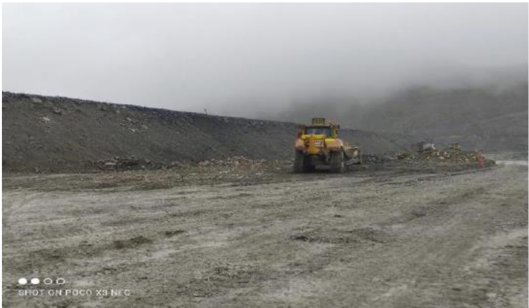
Fotografía: Conformación y compactación de material T3
