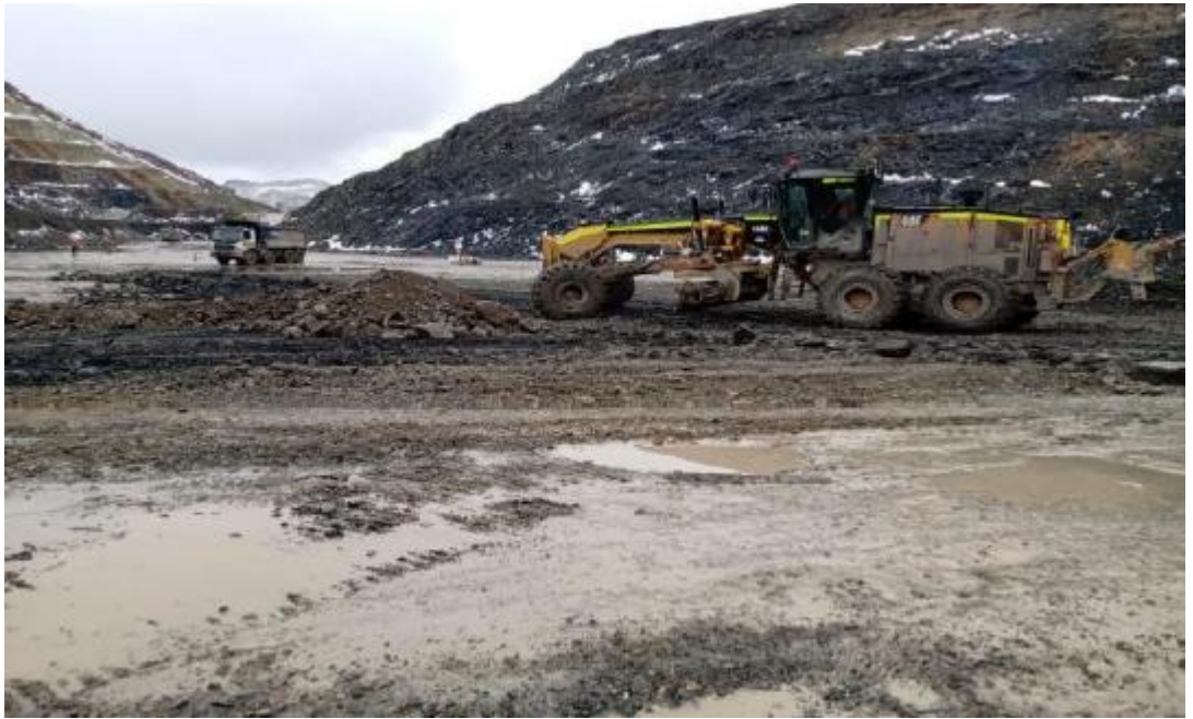
Fotografía: Mantenimiento de vías
