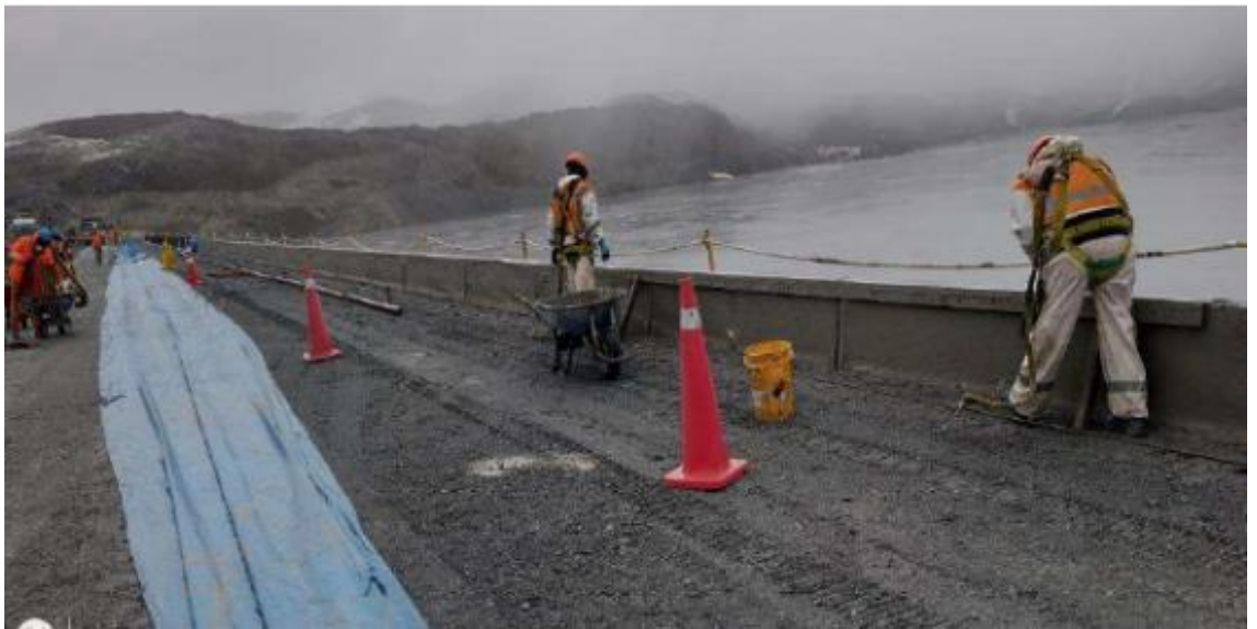
Fotografía: Solaqueo de concreto curb
