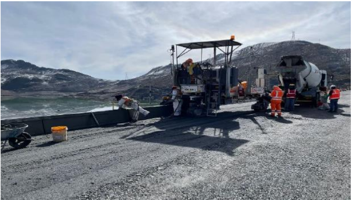
Fotografía: Vaciado de concreto curb
