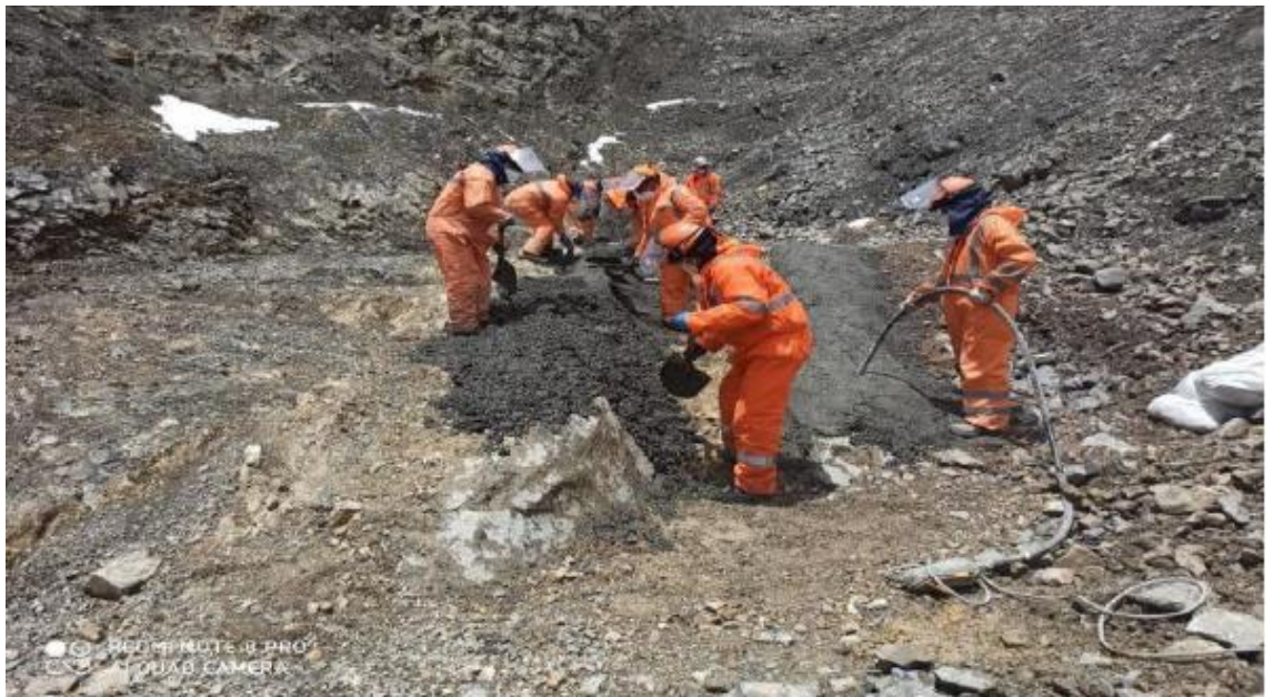
Fotografía: colocación de concreto dental en estribo oeste
