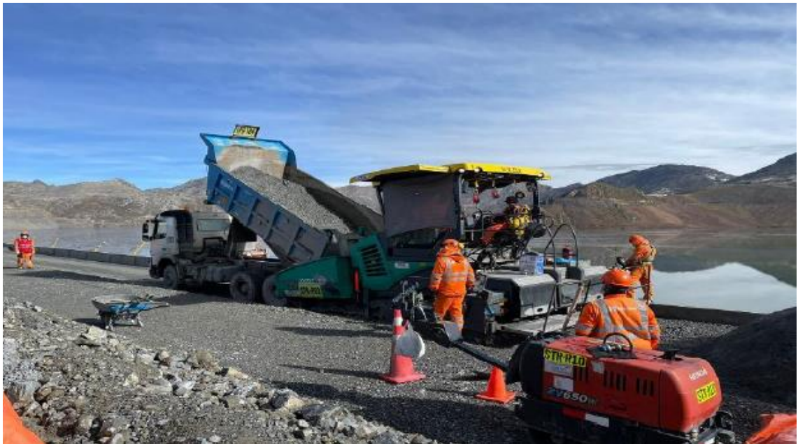
Fotografía: Descarga de Material T1
