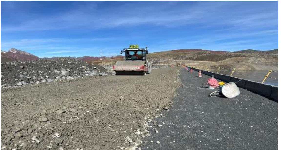
Fotografía: Conformación de Material T2
