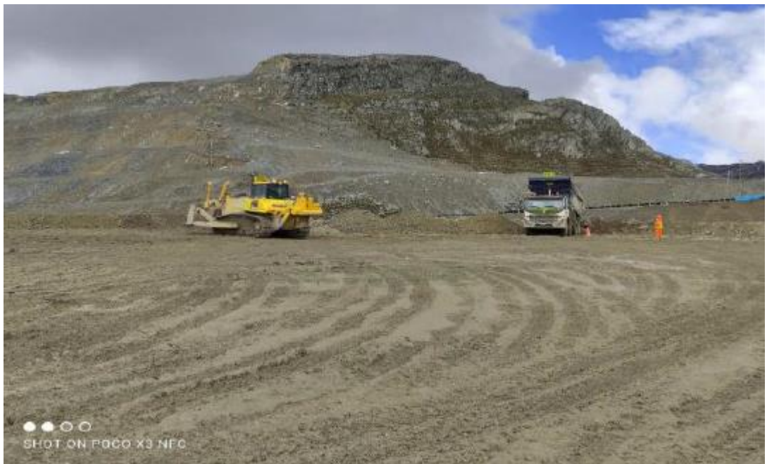
Fotografía: Descarga y conformación de materiales en botadero (DMI)
