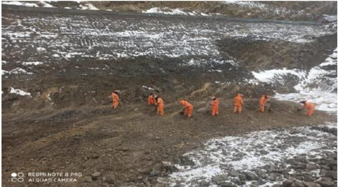
Fotografía: Limpieza manual del estribo en lado este
