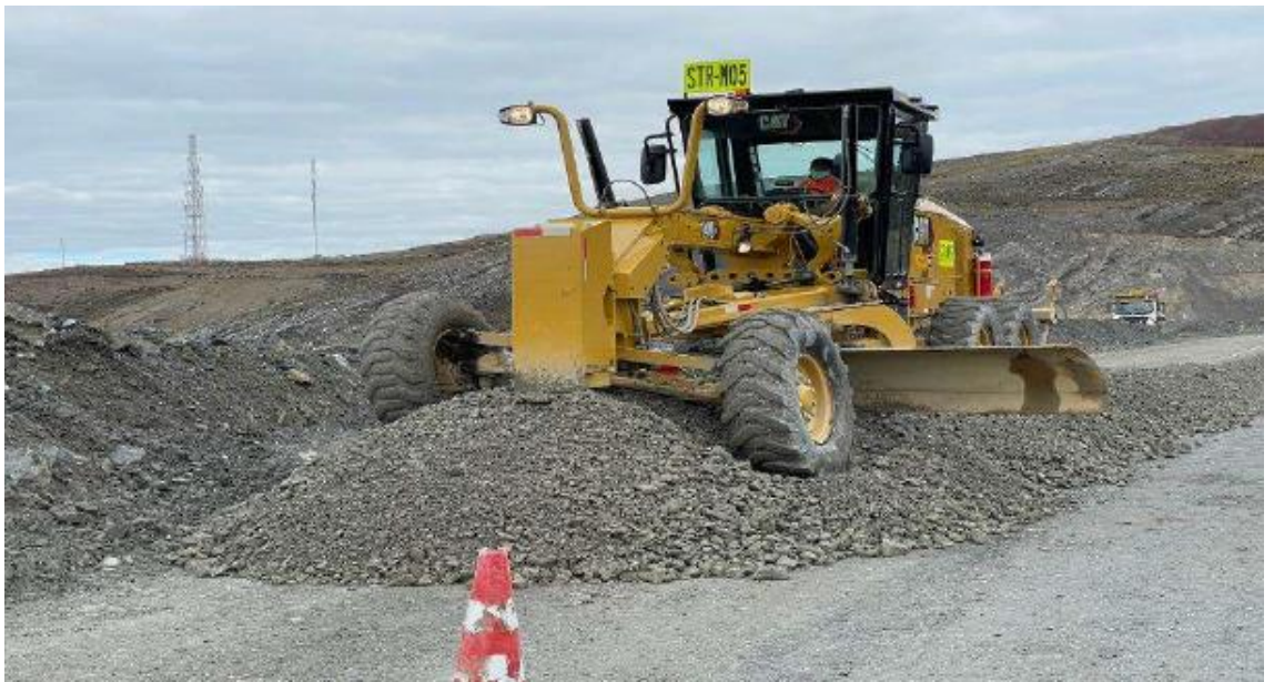
Fotografía: Conformación de Material T2
