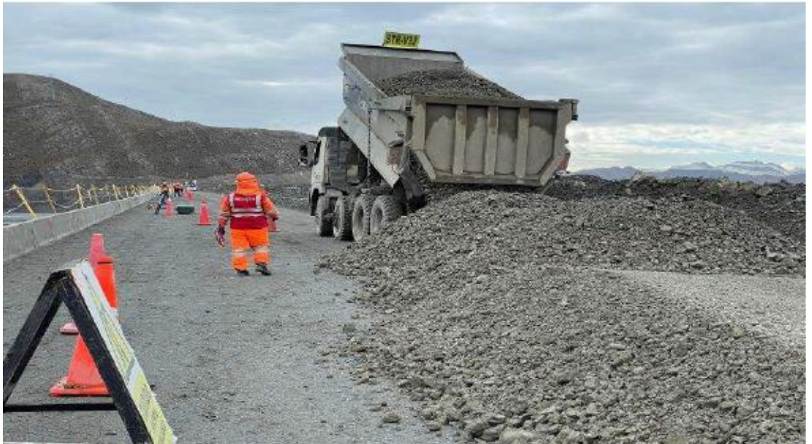
Fotografía: Descarga de Material T2
