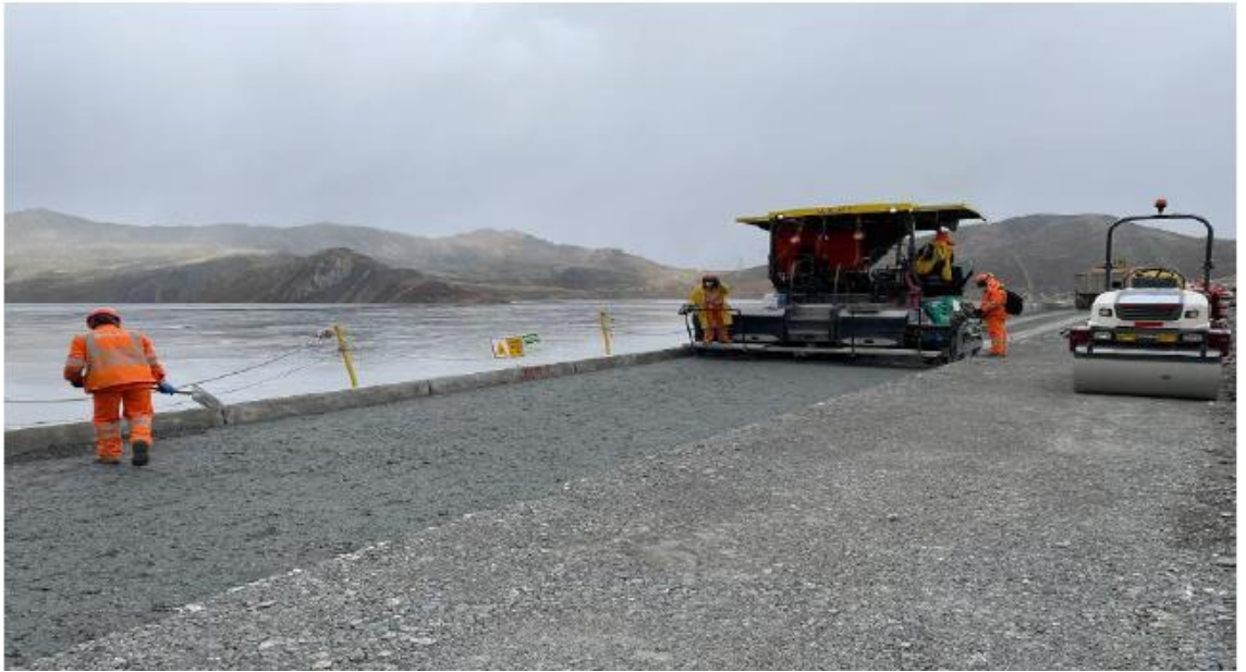
Fotografía: Conformación de Material T1
