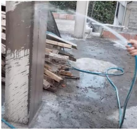
**Imagen 08:** Curado de concreto endurecido
