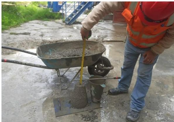
**Imagen 09:** Consistencia del concreto
