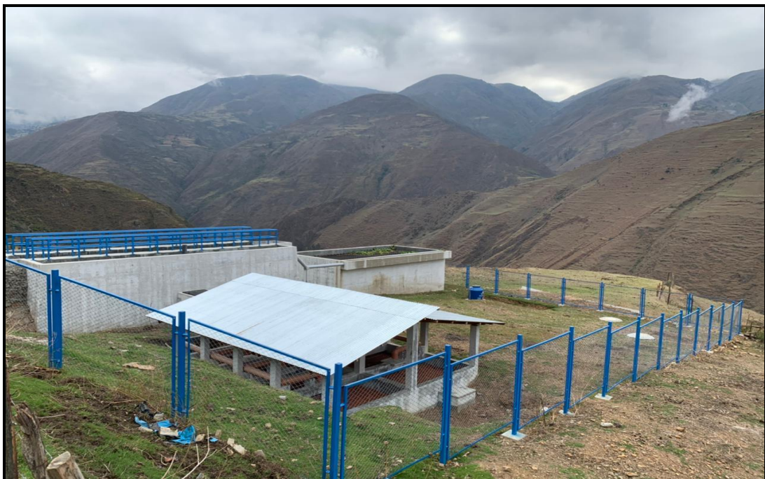
Vista de la planta de tratamiento implementado en el centro poblado de Antapirca
