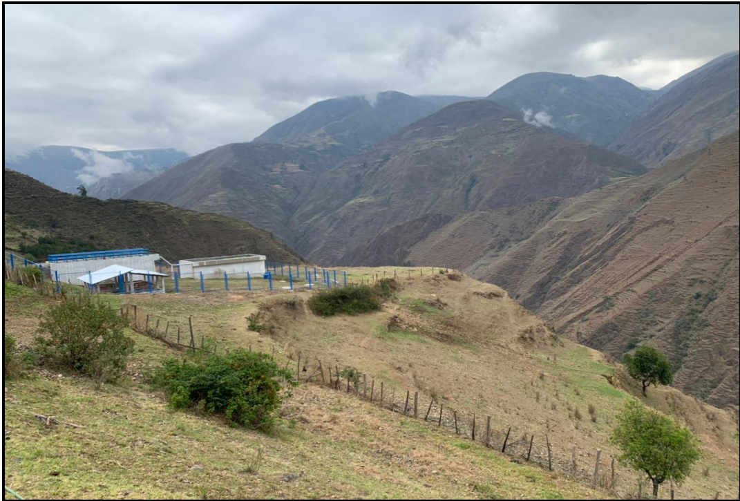
Vista de la planta de tratamiento implementado en el centro poblado de Antapirca
