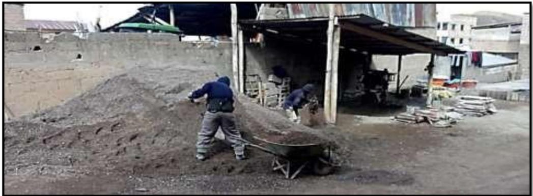
Seguidamente se agrega 1 bolsa de cemento para poder ser mezclado con la arena.
