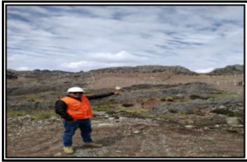
Figura 4. Ejecución de Obras de Remediación de 30 componentes de Pasivos Ambientales Mineros.
