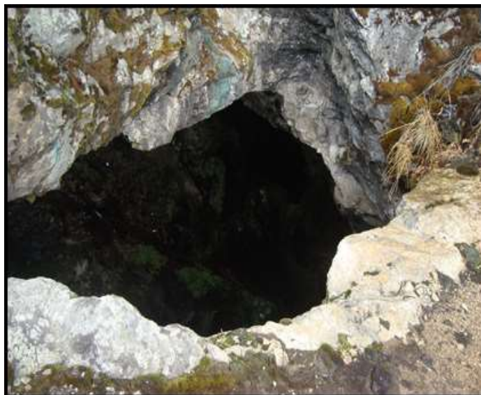
Ilustración 11. Pozo con una embocadura colapsada
