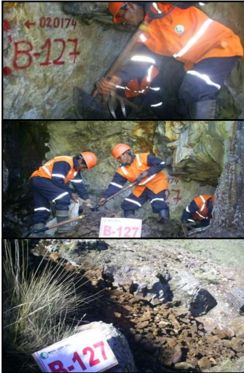
Se realizaron las partidas de colocación de material de desmontera no generadora DA-127 dentro de la mina.
