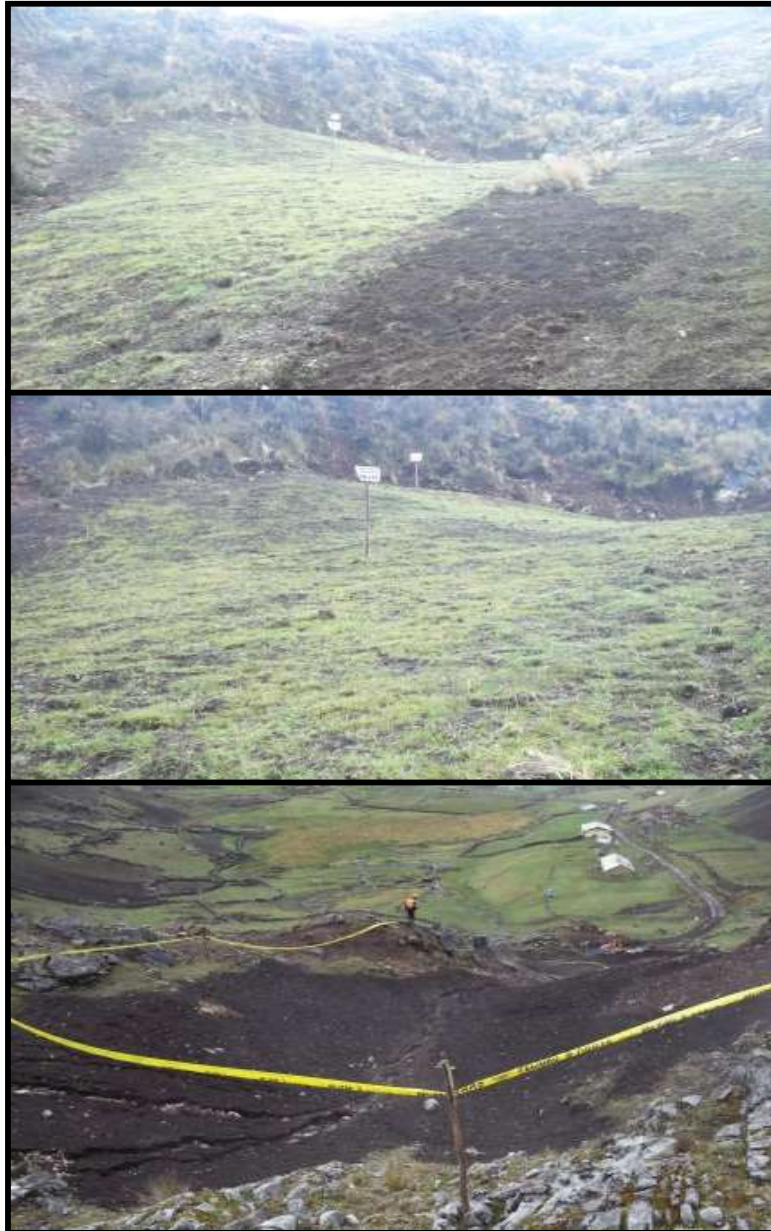
En la fotografía se observa la desmontera erosionada por las aguas de las lluvias se remedió y presentación final de la bocamina y desmontera con vegetación.
