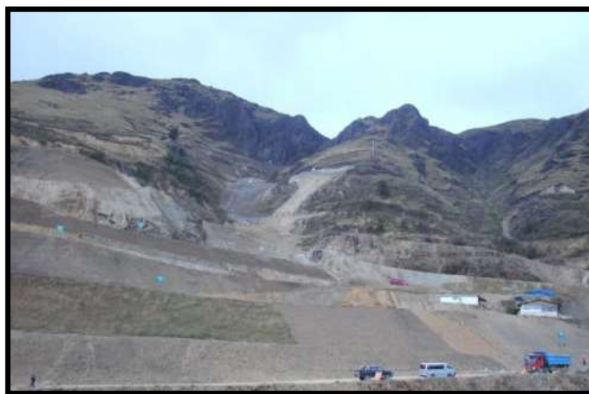
Figura 2. Ejecución de Obras de Remediación de 64 Pasivos Ambientales Mineros de El Dorado.
