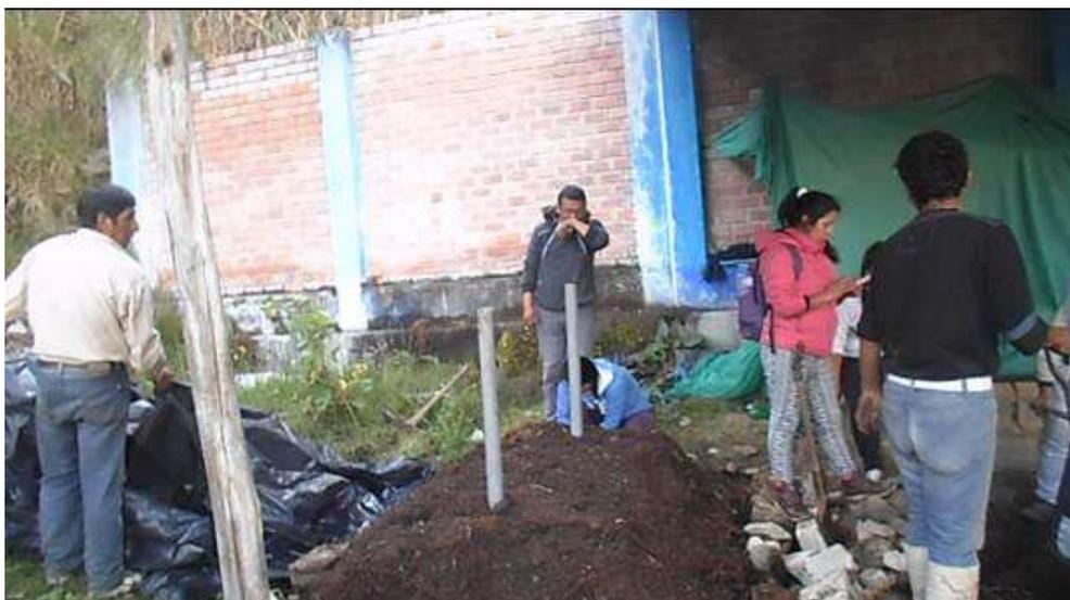
**Nota:** La presente figura muestra labor de colocación de tubos de PVC, para proveer de aireación al compost. Fuente: Elaboración propia del investigador
