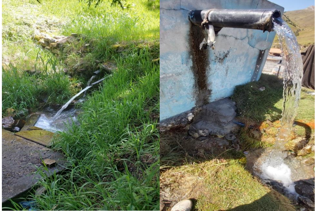
Fig 08 Captación y reservorio del CC PP Pariamarca (puntos de muestreo)
