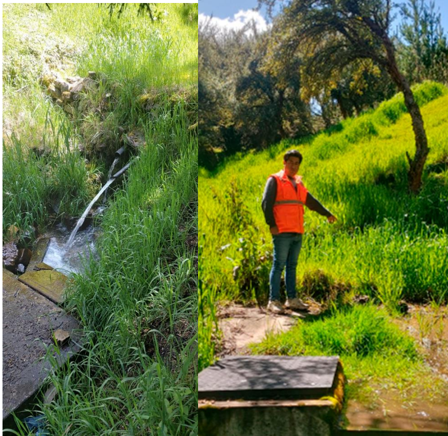
Foto 03 Tesista mostrando la captación de agua para Pariamarca
