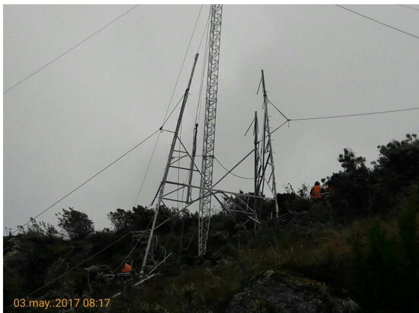
**Figura 20. Tendido de conductores, La Unión Leticia - Tarma**
