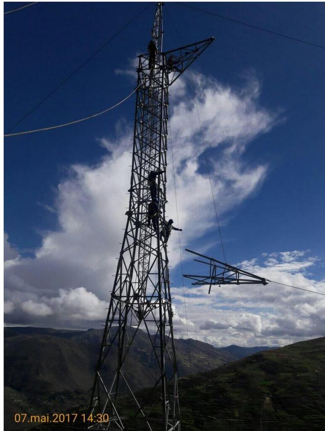
**Figura 19. Ensamblaje de torre vértice, Palca – Tarma**
