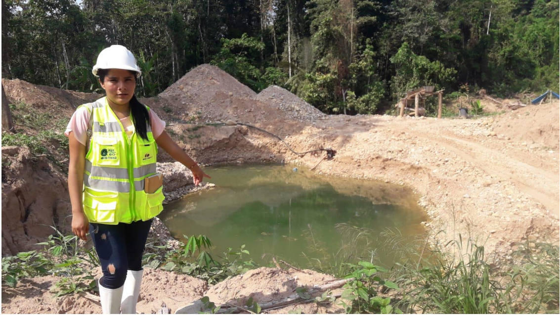
Fotografía N° 05: Pozas de sedimentación sin señalizaciones ni tratamientos.
