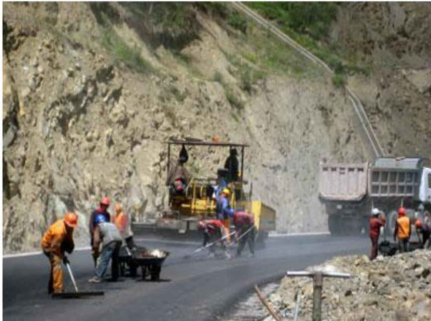
Fotografía N° 1: Realización de trabajos de asfalto, ANTES de implementar el Plan de Seguridad y Salud ocupacional (falta de uso de EPPs, uso de proceso deficientes)
