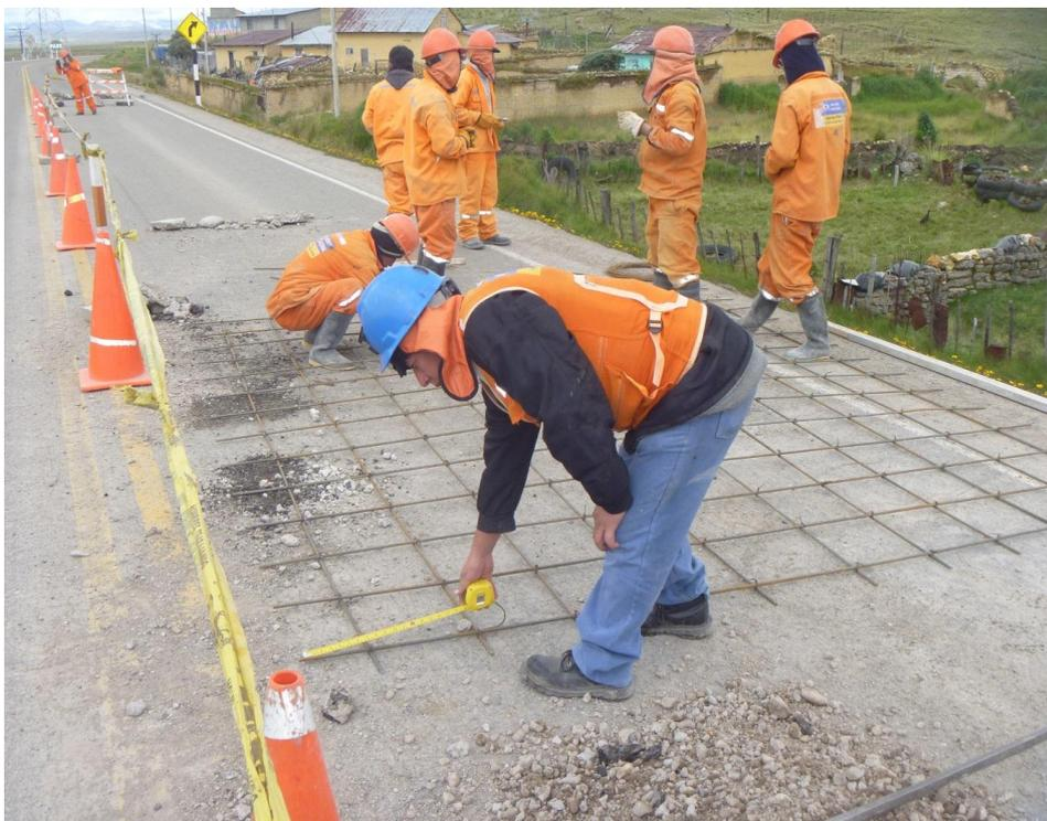
Fotografía N° 4: DESPUES de la implementar el Plan de Seguridad y Salud ocupacional. Área del trabajo señalizado con conos.
