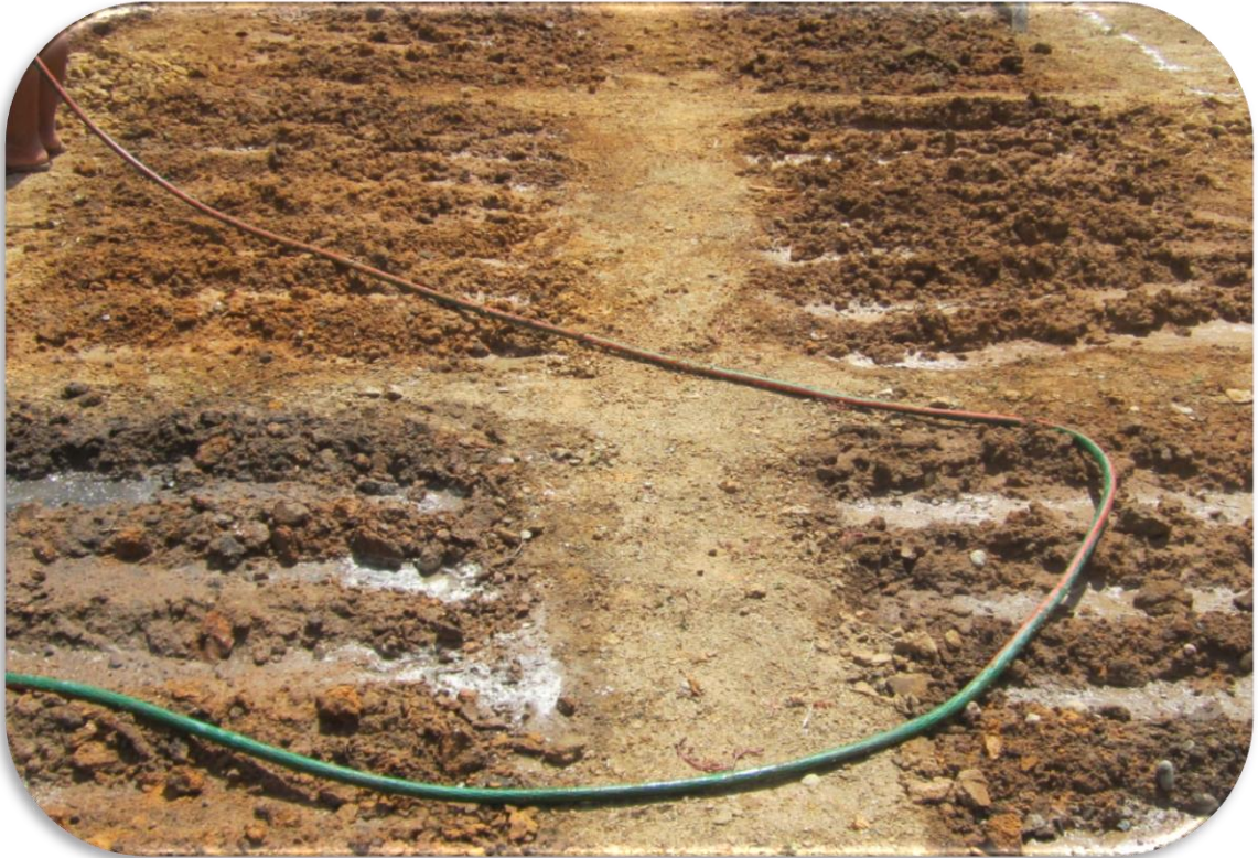
Foto 01: PREPARACIÓN DEL TERRENO
